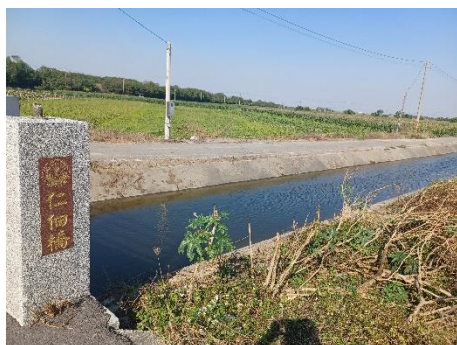
東石支線通水情形
