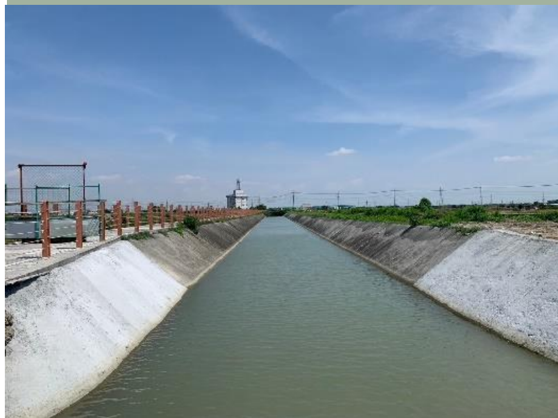
混凝土內面工
