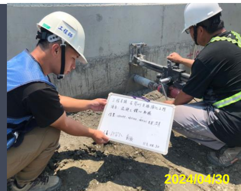
混凝土鑽心取樣
