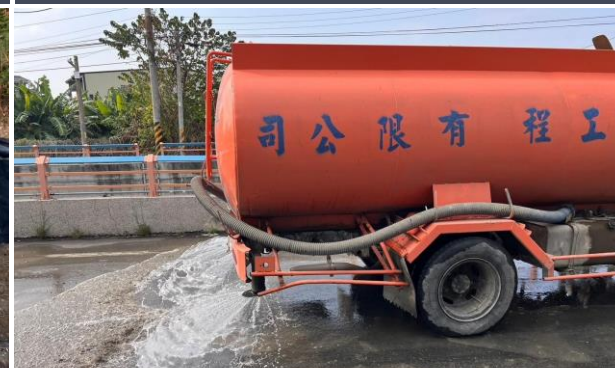
施工期間定期灑水清洗道路
