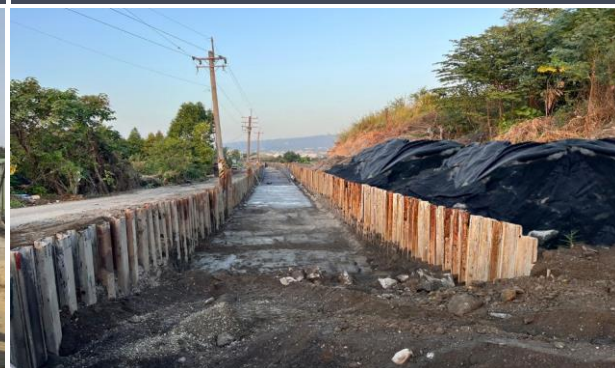
防塵網確實放置
