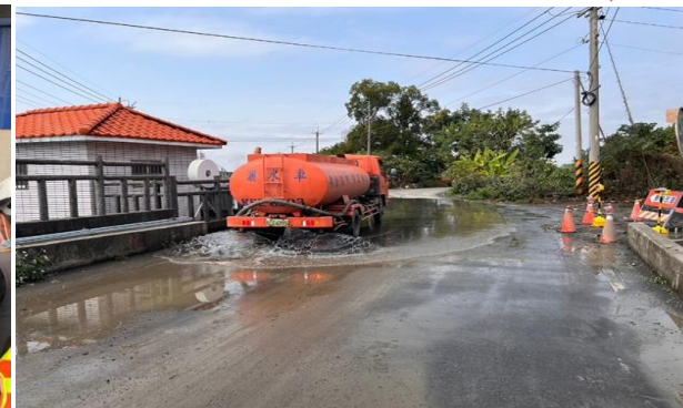
施工期間定期灑水清洗道路
