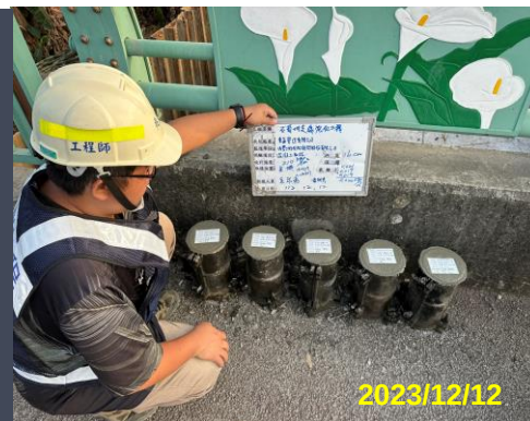
混凝土圓柱試體取樣
