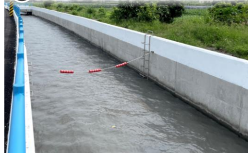
② 設置安全梯及安全繩索
