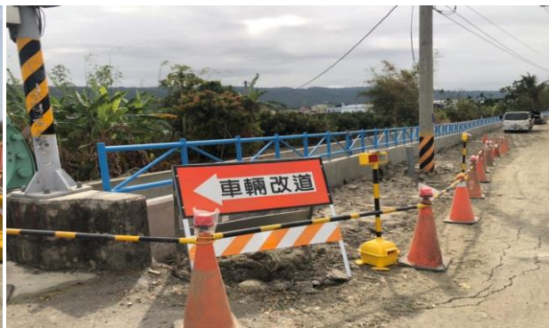
施工期間落實交通維持
