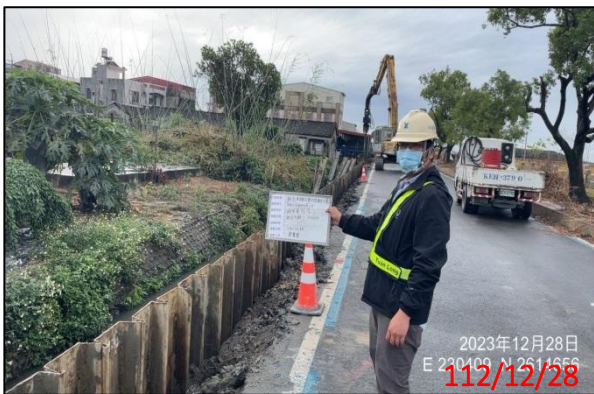
鋼板樁打設抽查
