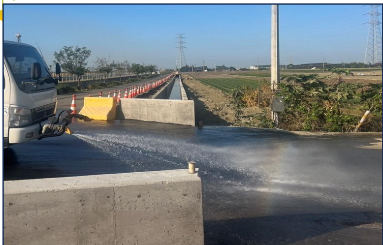
工區路面灑水防塵
