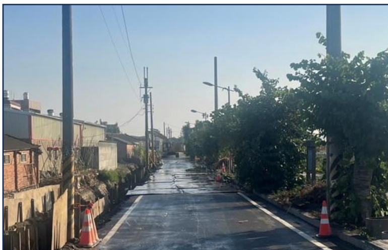
工區路面灑水防塵
