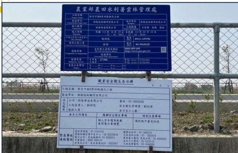
工程及職安告示牌設立
