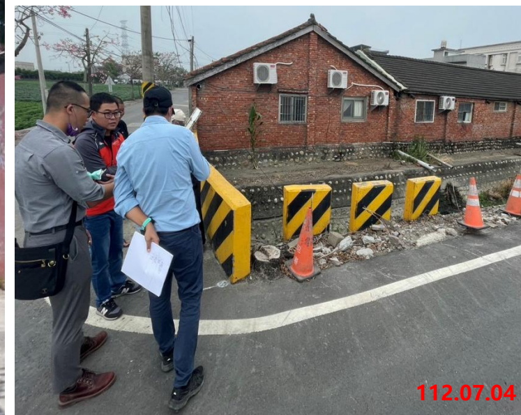
施工中協調會勘
