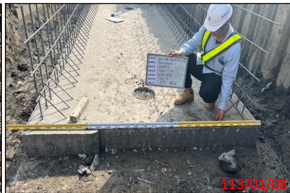
基礎完成面抽查
