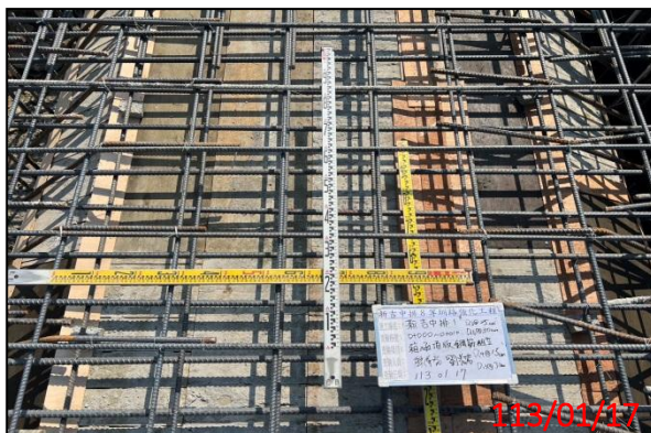
箱涵鋼筋工程
