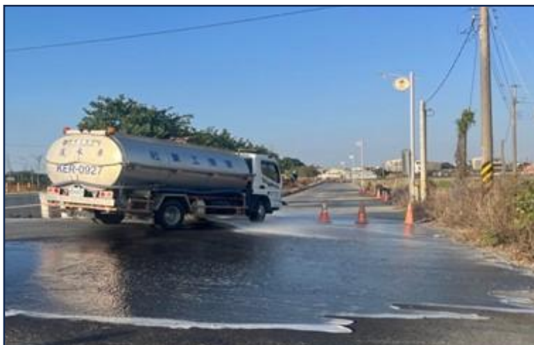
工區路面灑水防塵
