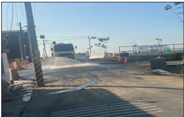
工區路面灑水防塵
