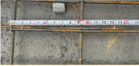
圳底使用混凝土塊墊高，有PC襯底時為5cm±0.6cm
