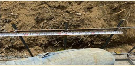
主筋排紮間距尚符合圖說25cm，副筋搭接≥40cm
