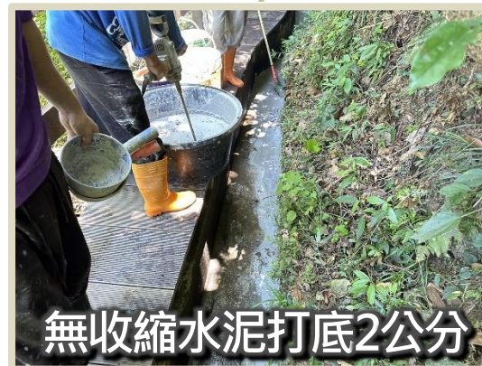
水圳破損處修補
