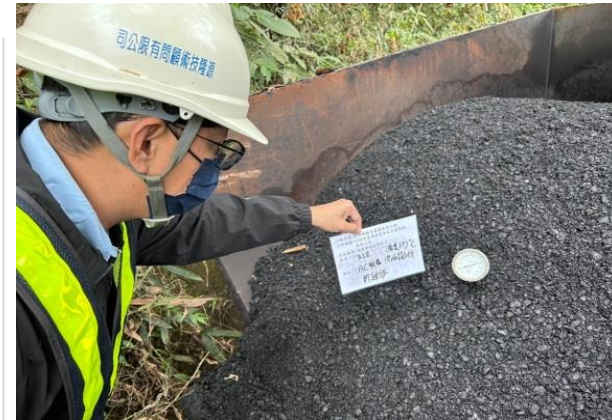
4 鋪裝前查驗混合料溫度
