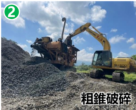
工地打除混凝土料
