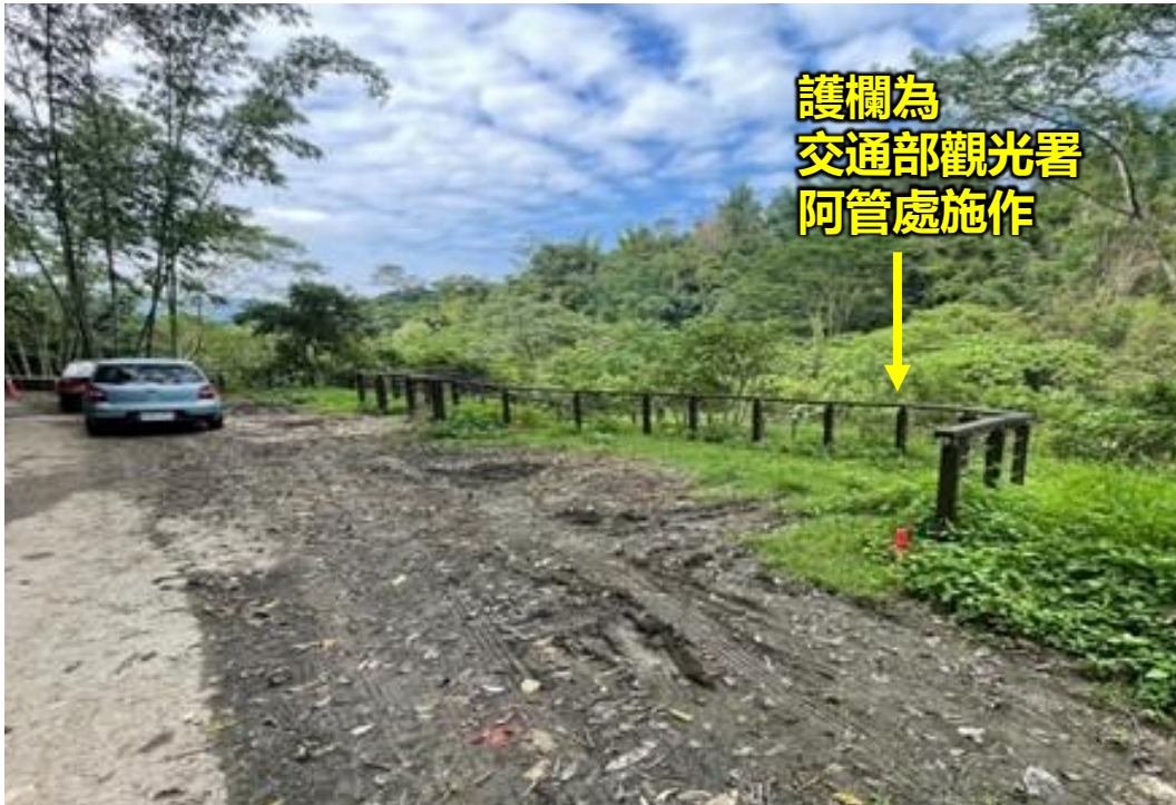
(施工前) 路邊空間地面泥濘
