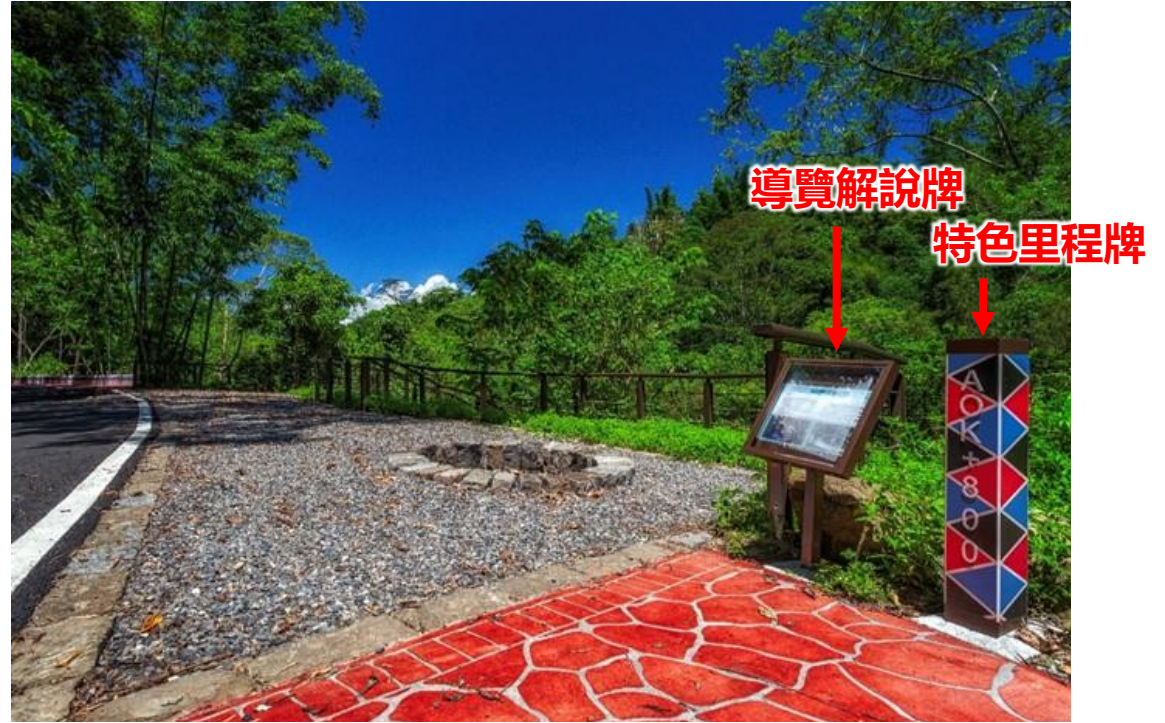
(施工後) 改善周邊環境
