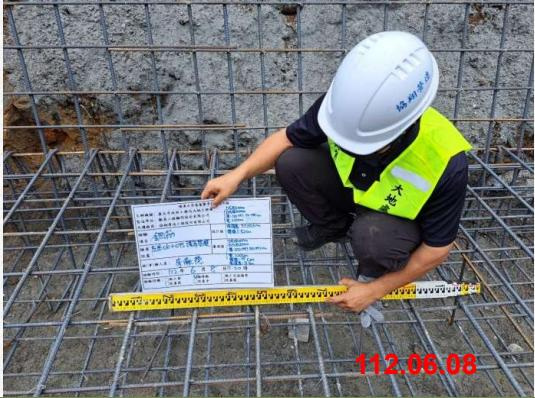
護岸鋼筋測量
