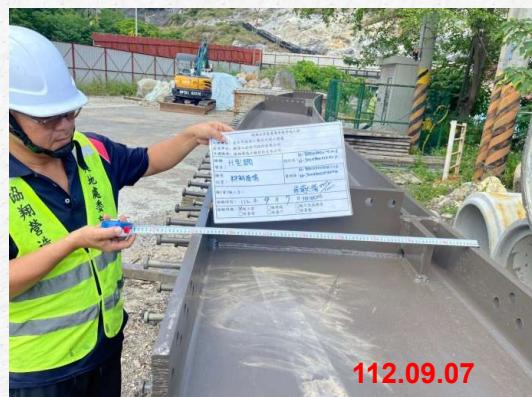
景觀橋H型鋼尺寸測量
