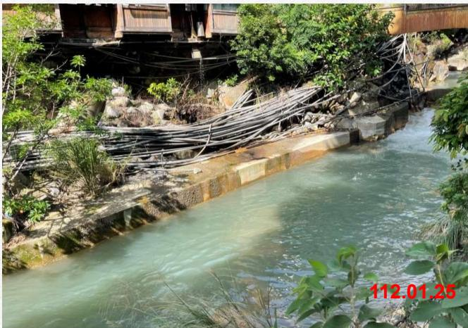
溫泉管線及廢棄管路阻礙護岸施工
