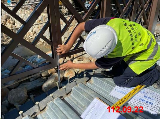
景觀橋鋼構尺寸測量
