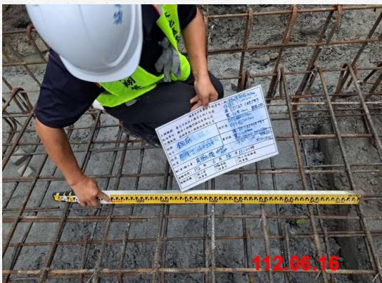
固床工鋼筋測量
