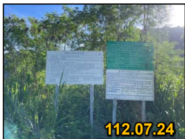
112.07.24 設置職業安全衛生告示牌
