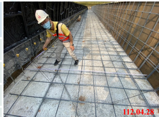
鋼筋模板檢查
