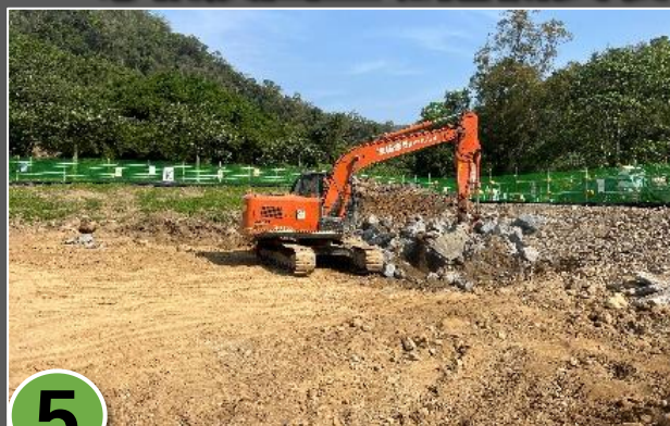
混凝土破碎處理
