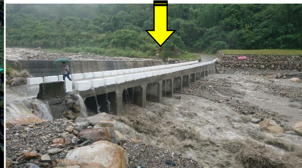
臺中市政府改建為 橋涵 (106年)
