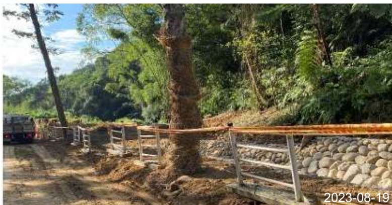
開挖邊坡警示設施設置
