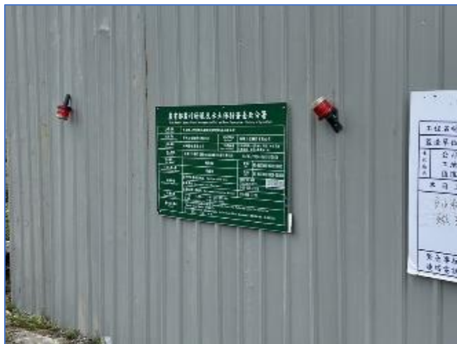
施工圍籬及警示燈設置
