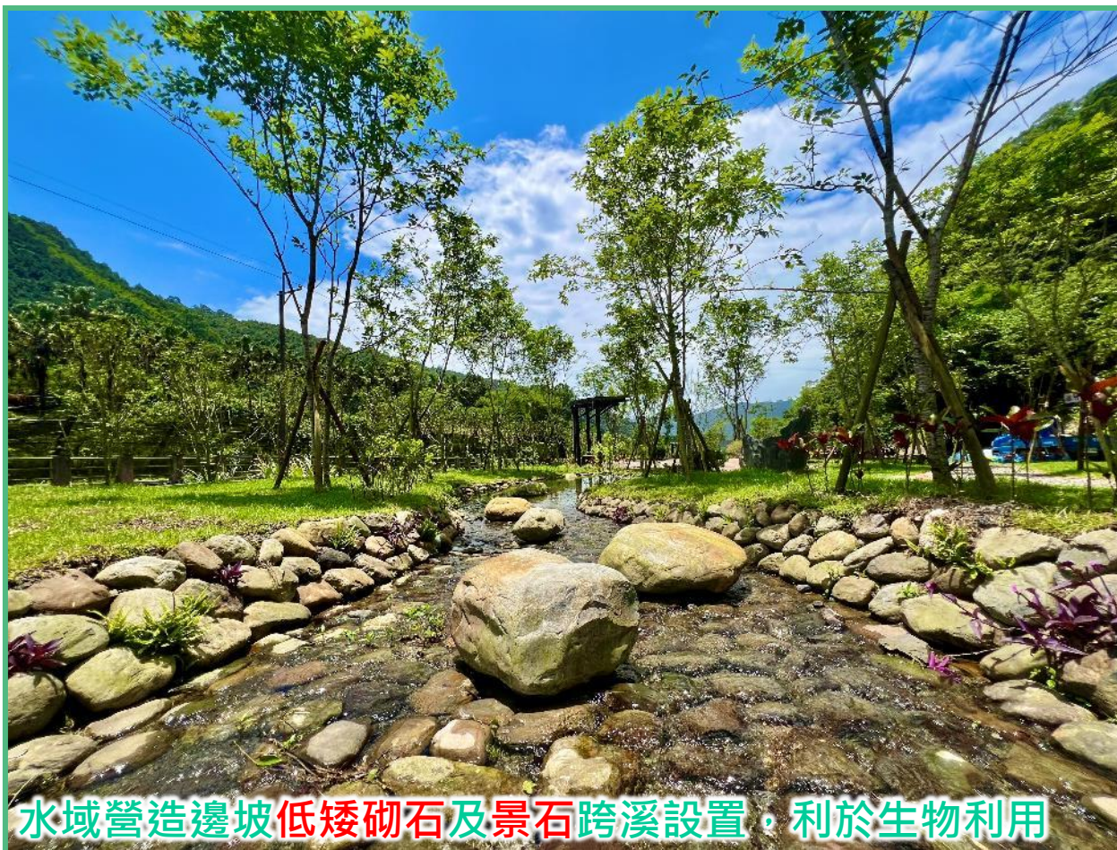
設計 低落差跌水消能 ，將漫流 水平緩導流 至崩山湖野溪
