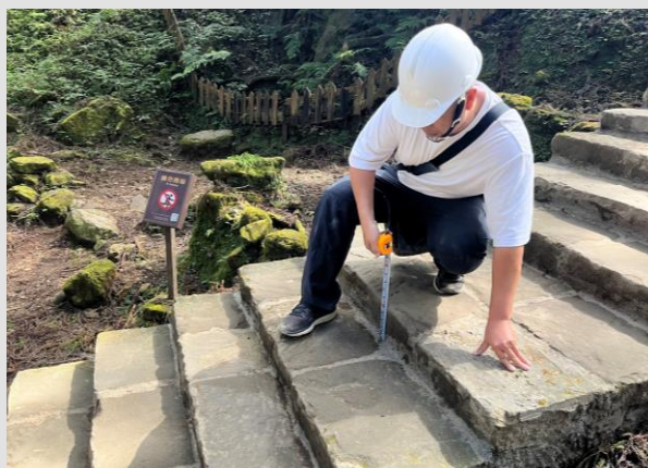
階梯步道石板鋪設級高查驗
