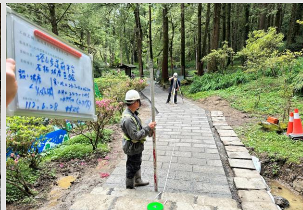
平面步道石板斜坡坡度查驗
