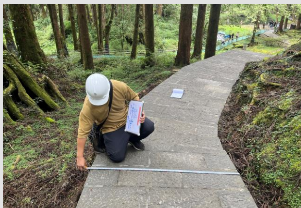
平面步道石板鋪設寬度查驗
