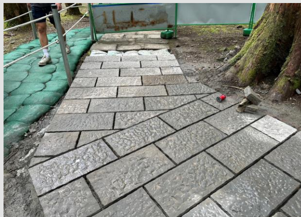
步道新購石板石板試鋪查驗
