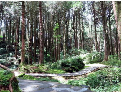
阿里山國家森林遊樂區姊妹潭步道，因部分石板破裂、鬆動，自19日起至11月15日部分封閉進行改善工程，採分區施工方式。（嘉義林管處提供）中央社記者黃國芳傳真 112年4月13日
