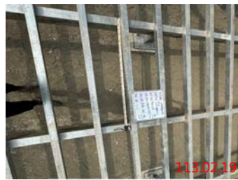
結構用鋼料檢查
