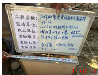
模板施工檢查
