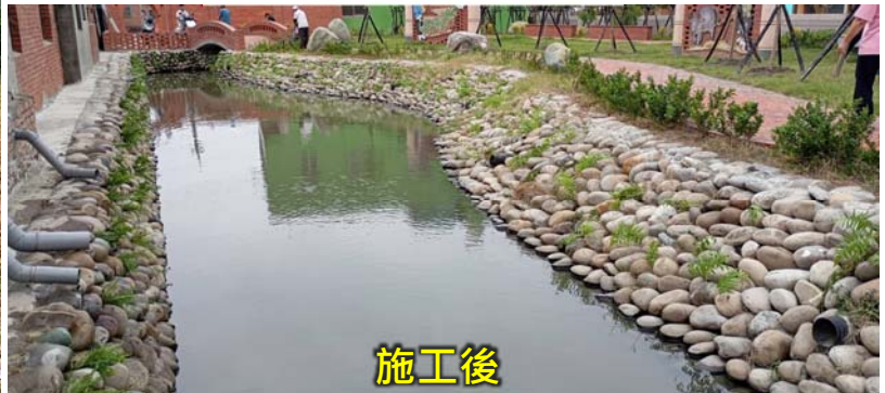
施工階段-人工施工
