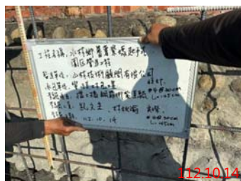
鋼筋綁紮檢查
