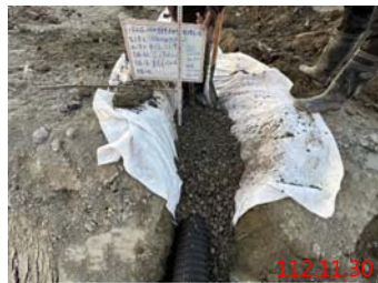
透水管碎石回填檢查
