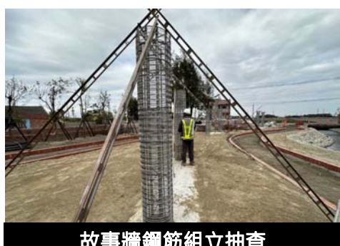
擋土牆鋼筋查驗
