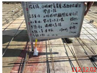
混凝土高程檢查
