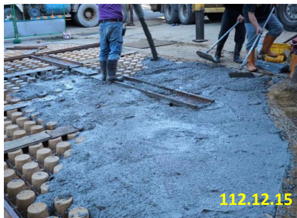
4. 混凝土鋪設
