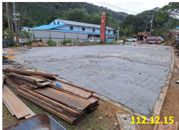
5. 混凝土鋪設完成
