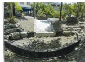
溜槽砂坑施工
