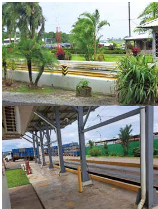
圖三、在進場處設置大型地磅站，可於集貨包裝場鏈結收集果園產量資料。
