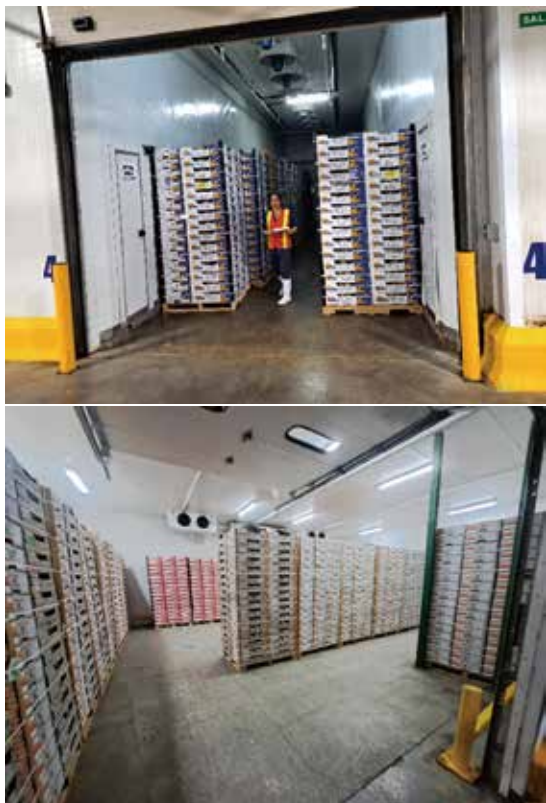
圖六、已完成棧板作業後以堆高機移入壓差或風速較強的冷藏庫進行預冷及暫貯。
