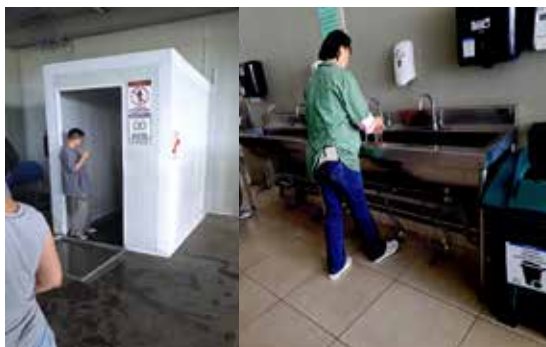
圖一、雙門式入口(附鞋底消毒池)及洗手設備等附屬設施。
