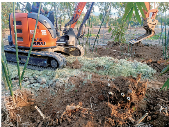
▲ 圖 2. 利用小型挖土機進行冬季清竹頭作業，明顯節省工時及人力。(攝於桃園市龍潭區廖文彬農友處)
