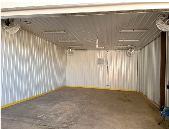
(c) 貯藏庫內有排風扇 ( 夜間開窗通風降溫 ) 及循環扇對流空氣。
