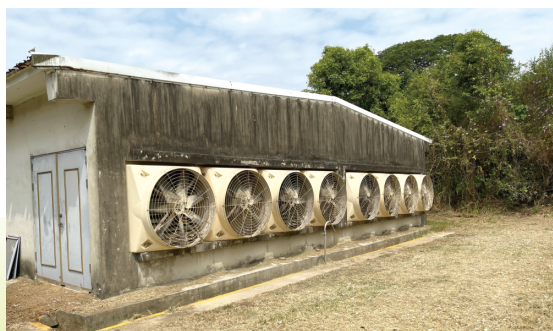
▲圖1. 雞舍變更為變頻負壓風扇後可節電減碳
