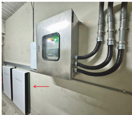
▲圖1. 畜試所密閉式水簾蛋雞舍示範場導入的儲能系統（紅色箭頭處）
