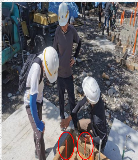
預埋地樑不銹鋼螺栓
