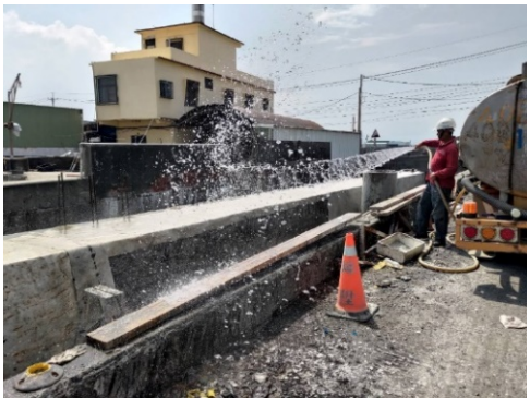
冠牆混凝土養護施作
