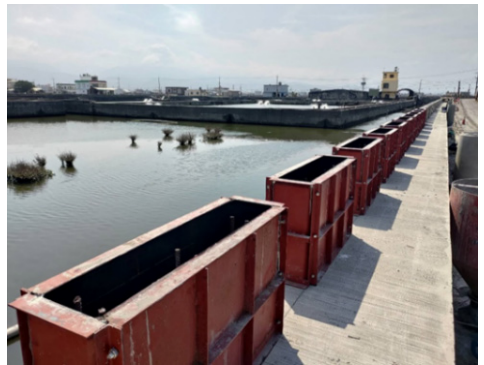
護欄模板組立施作
