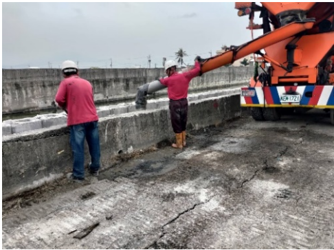
護岸245kgf/cm 2 ，混凝土澆置施作
