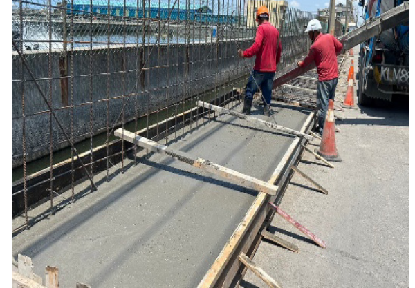
收邊牆基礎混凝土澆置施作
