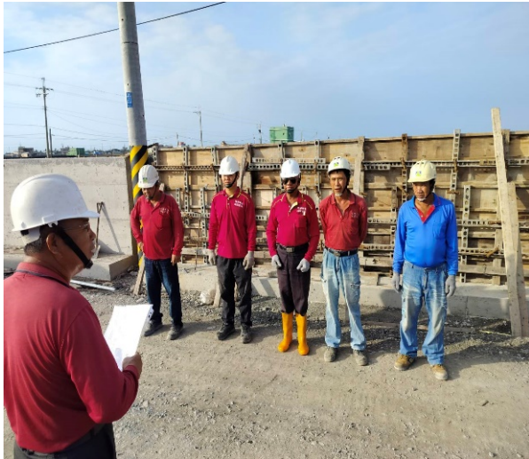
施工前危害告知
