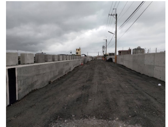
收邊牆拆模後
