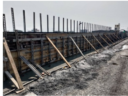
冠牆模板組立施作
