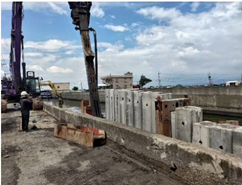
預力混凝土板樁 打設施作
