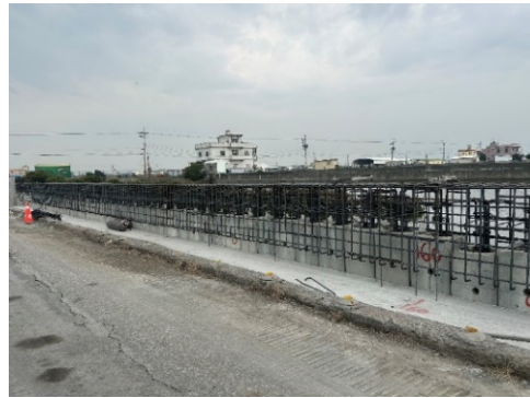
冠牆鋼筋綁紮施作
