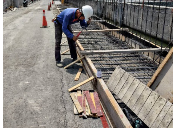
收邊牆基礎模板組立施作
