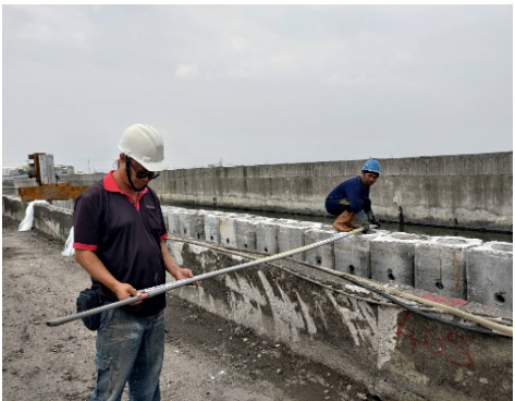
填縫袋量測約4M施作
