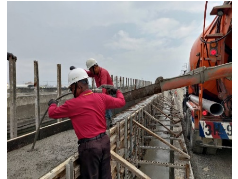
冠牆混凝土澆置施作
