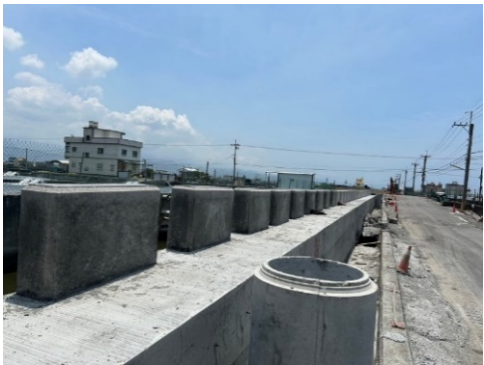
冠牆及護欄完成後
