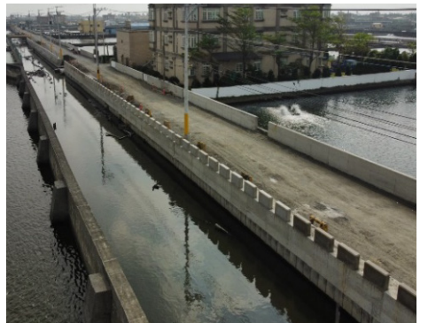
冠牆及護欄完成後
