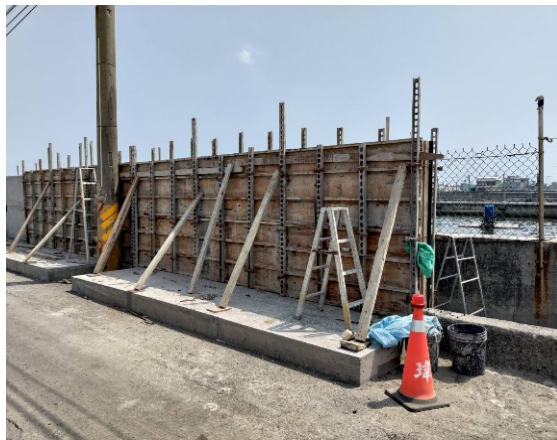
收邊牆牆身模板組立
