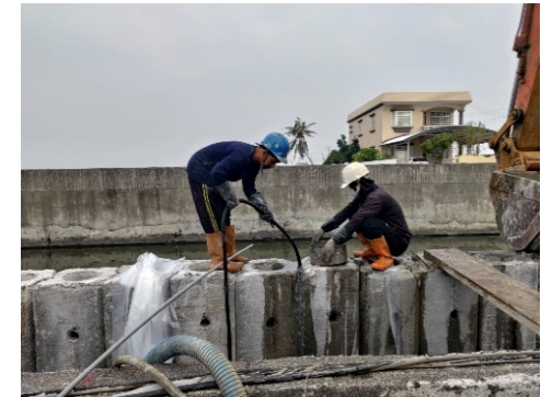
填縫孔沖洗施作
