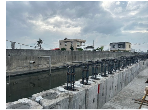
鋼筋籠放置施作
