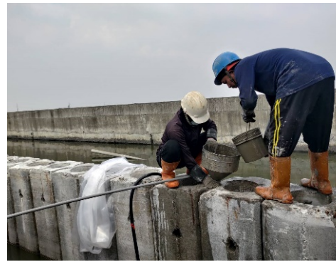
水泥灌漿施作
