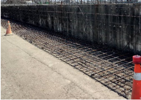
收邊牆鋼筋綁紮施作
