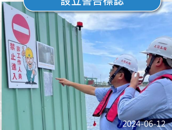
設立警告標誌
