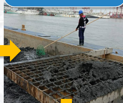
浚挖及雜物攔除
