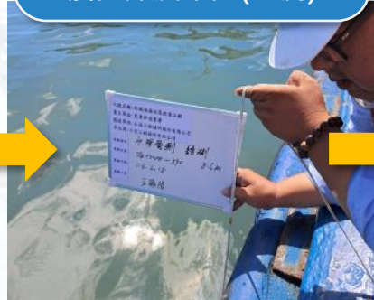
浚挖深度確認(垂測)
