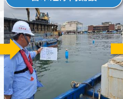
警示燈浮筒鋪設
