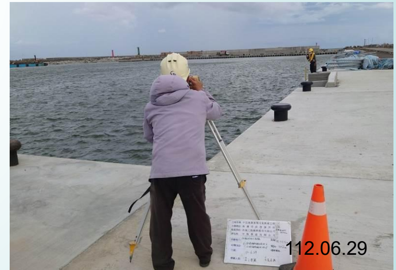
防舷材安裝抽查
