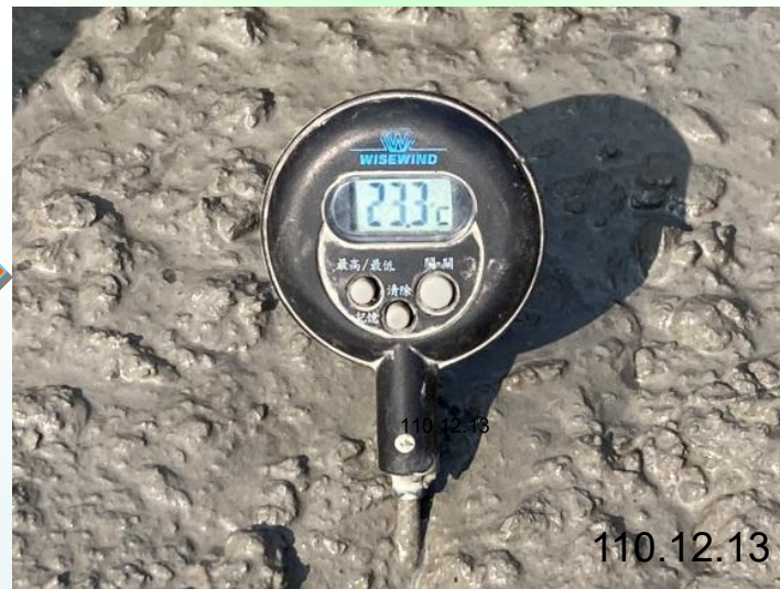
混凝土溫度量測
