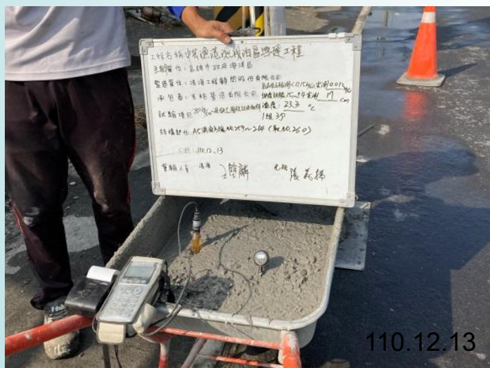
混凝土氯離子抽查
