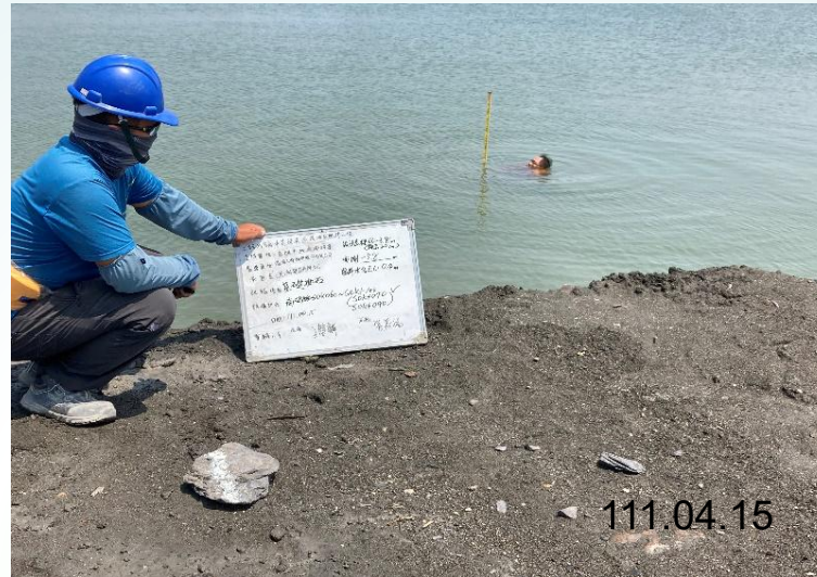
基礎拋石整平高程抽查
