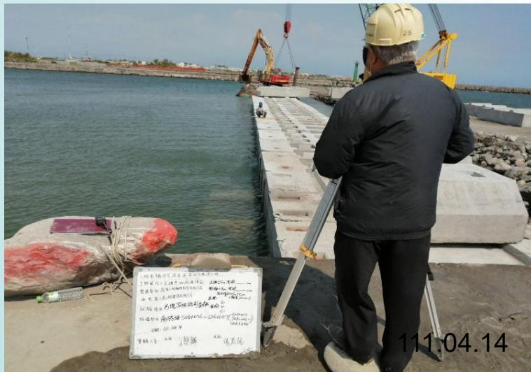
方塊吊放邊線抽查
