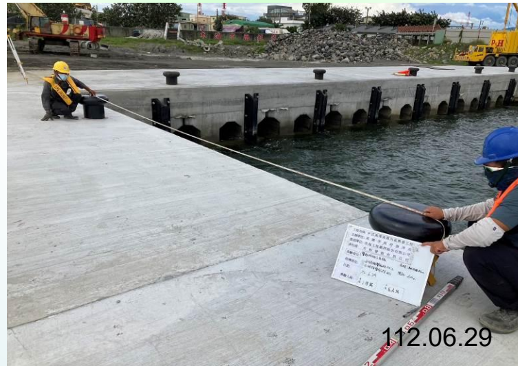
繫船柱安裝抽查
