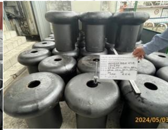
▲繫船柱料材料進場自主檢查
