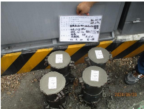
▲水溝澆置混凝土取樣
