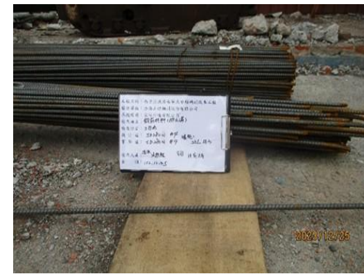
▲鋼筋材料進場規格查驗
