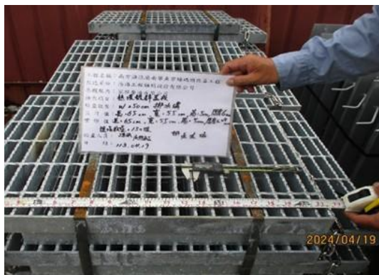
▲鍍鋅隔柵板材料進場尺寸查驗
