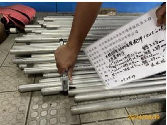
▲不鏽鋼管材料進場查驗取樣
