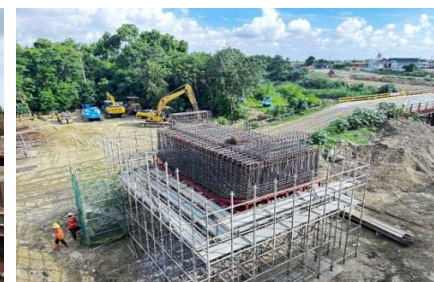
帽梁鋼筋施作
