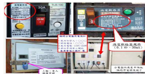
設置防止感電護圈
