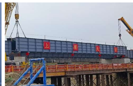
鋼構渡槽吊裝
