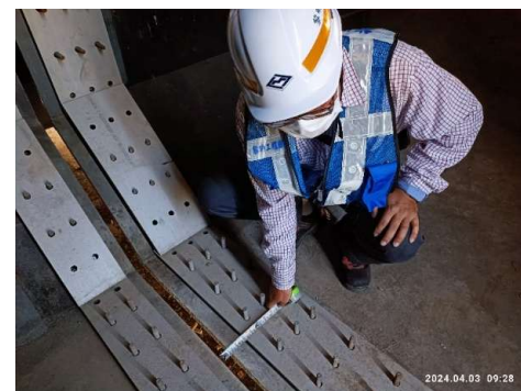
渡槽銜接段檢查
