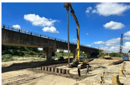
鋼板樁打設
