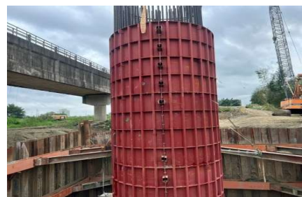
組模澆置混凝土
