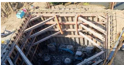
開挖擋土安全設施
