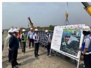
署長工地視察
