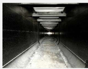
輸水鋼構渡槽
