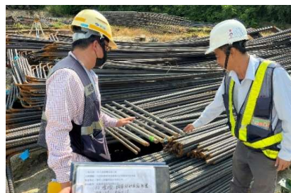
鋼筋材料取樣
