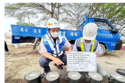
鋼筋材料取樣
