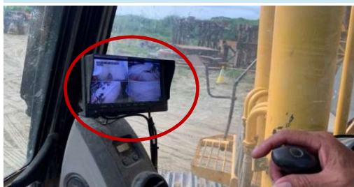
營建機具設置環景系統
