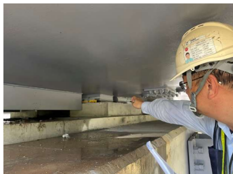
盤式支承檢查
