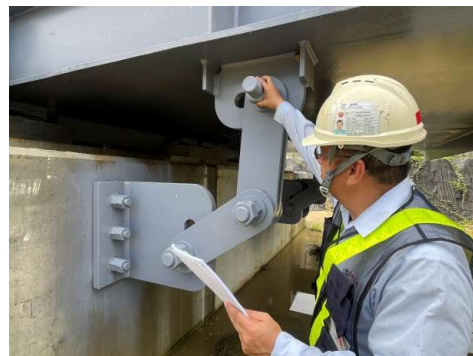
防落裝置檢查
