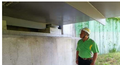
墩柱及支承墊
