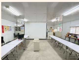
LED照明設備
