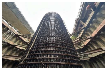
墩柱鋼筋綁紮
