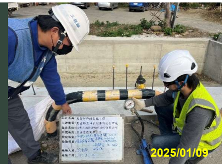
植筋拉拔試驗
