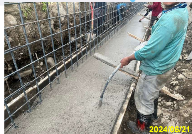
底版混凝土澆置
