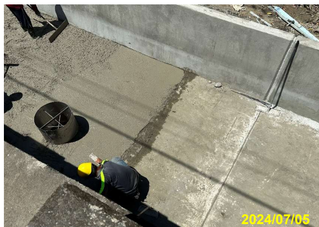
渠底混凝土澆置
