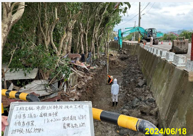
開挖高程測量
