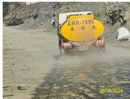
工區灑水抑制揚塵
