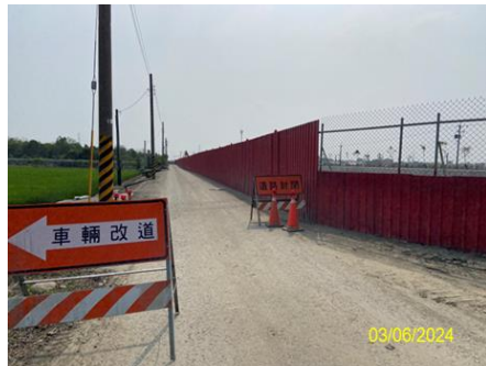
施工圍籬及夜間警示燈
