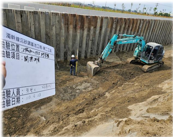
鋼板樁圍堰內作業情形
