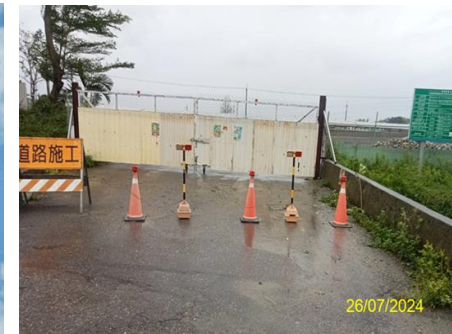
工區出入口交維設置
