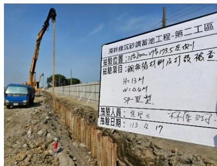
鋼板樁施工查驗
