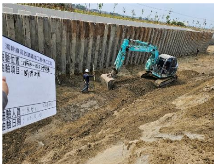
開挖測量查驗
