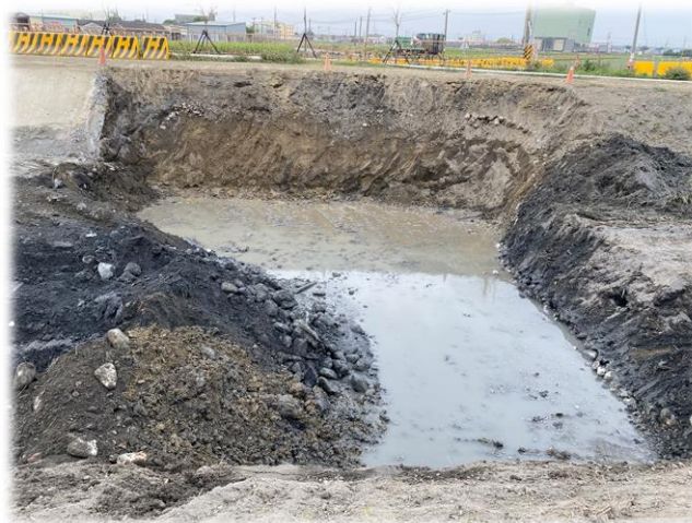
地下水略高於開挖面
