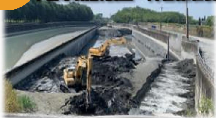
沉砂調蓄池入口與出口均低濁幹線約1m，可自然沉砂掛淤，減少下游水路淤積量，降低維管費用
