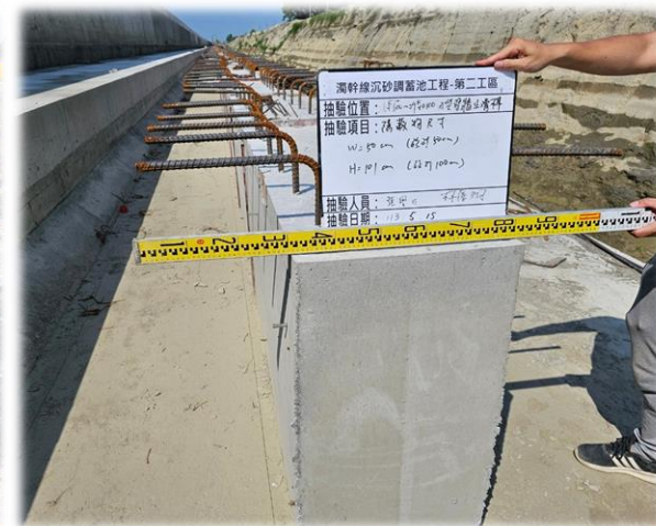
止滑樁現場預鑄
