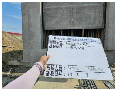
水閘門安裝查驗
