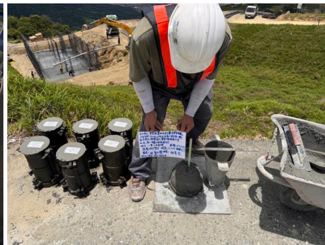
混凝土取樣送驗
