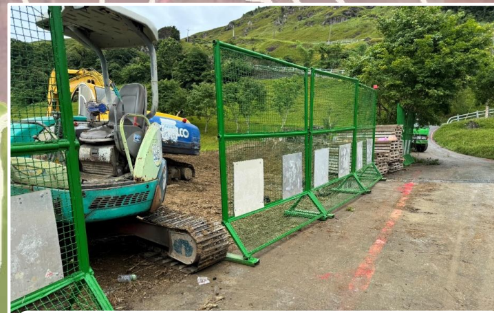
減輕：限制施工動線及材料暫置區域
