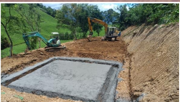
縮小：限縮施工範圍，盡量不挖除周邊次生林、灌木叢或草生地
