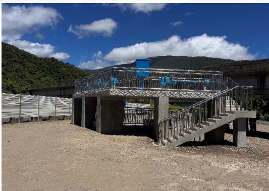
排砂道周邊回填
