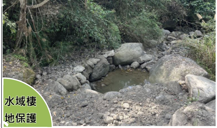
減輕-設置臨時沉沙池，避免影響下游水質
