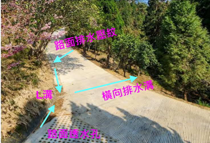
路面壓紋、透水孔+L溝+橫向排水溝
