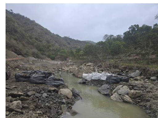
設置沉沙設施
