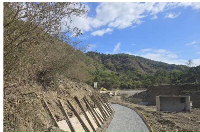
施工安全設施檢查
