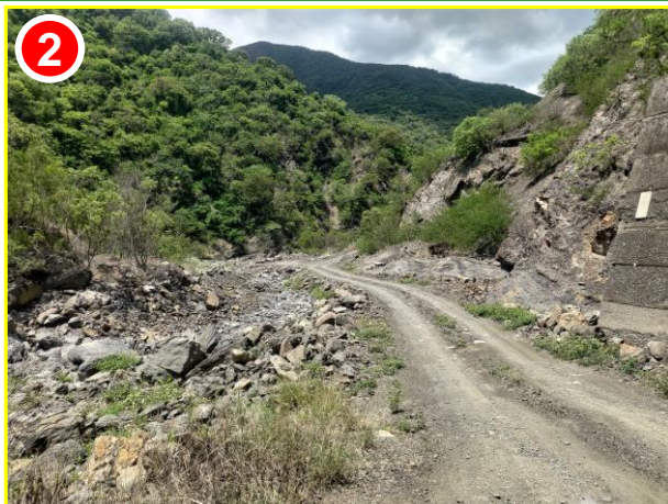
2 土砂淤積，影響通洪斷面
