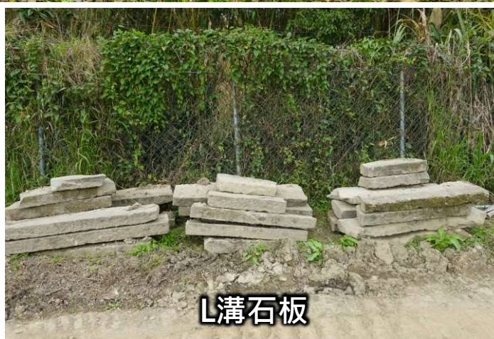
PC塊碾碎鋪底(既有粒料回填)
