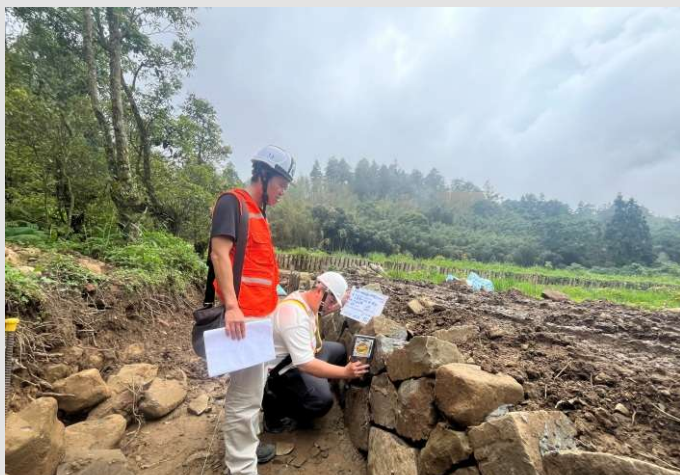
邊溝漿砌塊石溝試砌查驗
