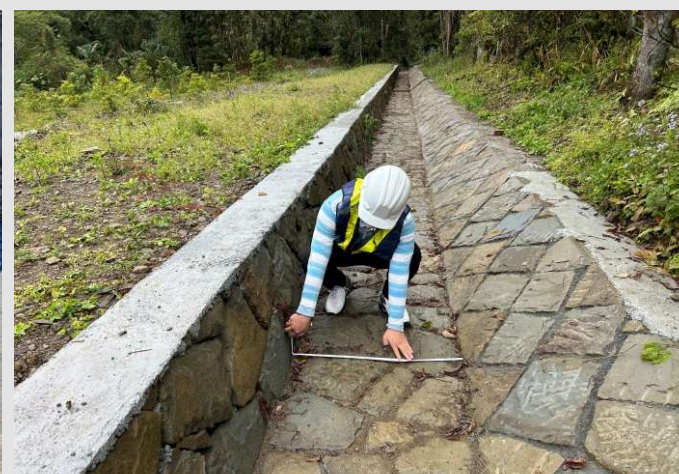
邊溝漿砌塊石溝石材查驗
