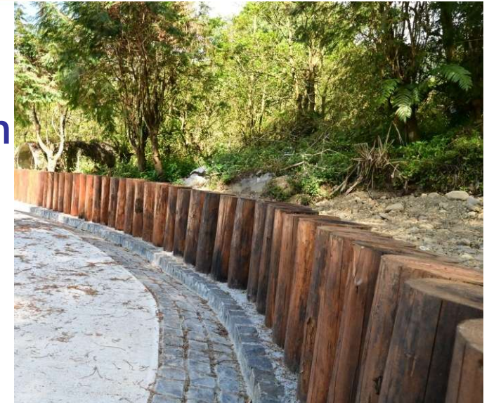
柳杉國產材 邊坡擋土&混凝土減量
