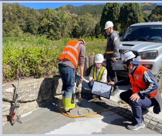
混凝土厚度鑽心檢測
