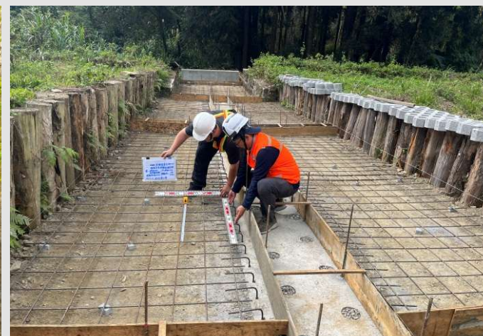
採穗園道路後段鋼筋查驗
