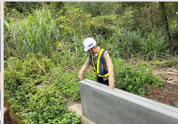
採穗園牆混凝土查驗
