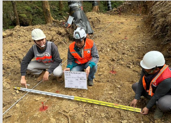
漿砌石護坡基礎開挖查驗
