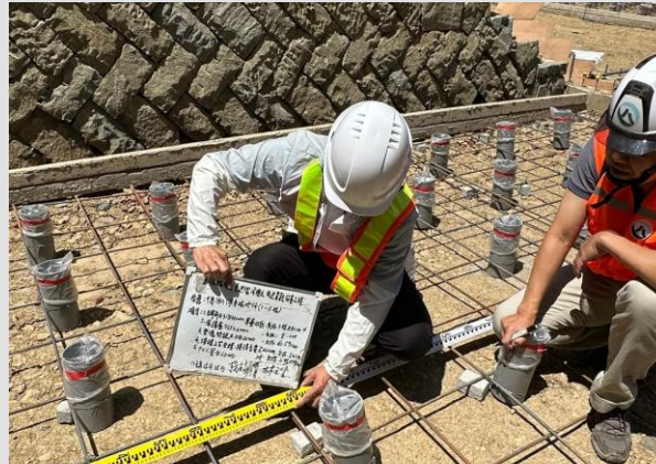
停車場地坪鋼筋及PVC管查驗
