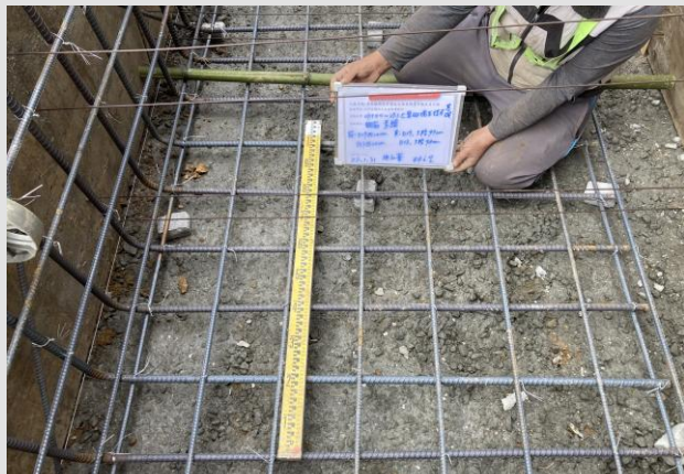
漿砌石護坡基礎鋼筋查驗
