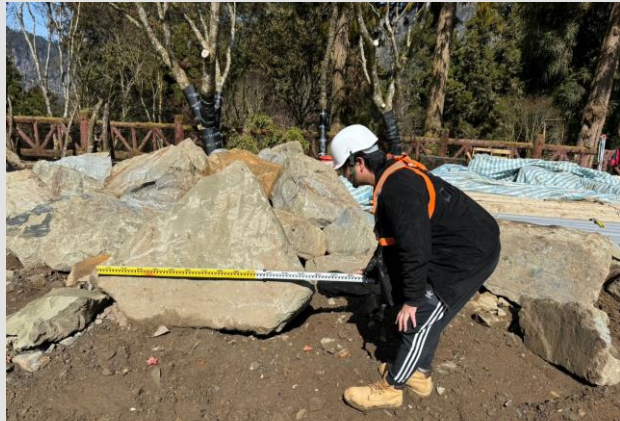
漿砌石護坡漿砌大塊石查驗
