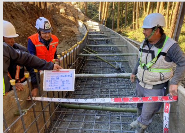
漿砌石護坡基礎模板查驗
