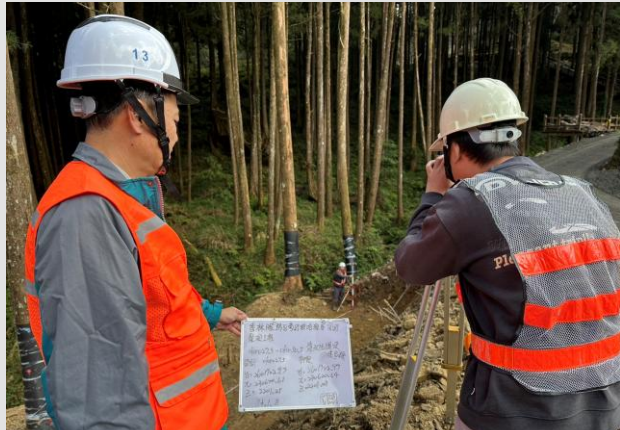
漿砌石護坡基礎放樣查驗
