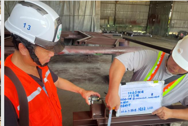
階梯及平台欄杆鋼構查驗
