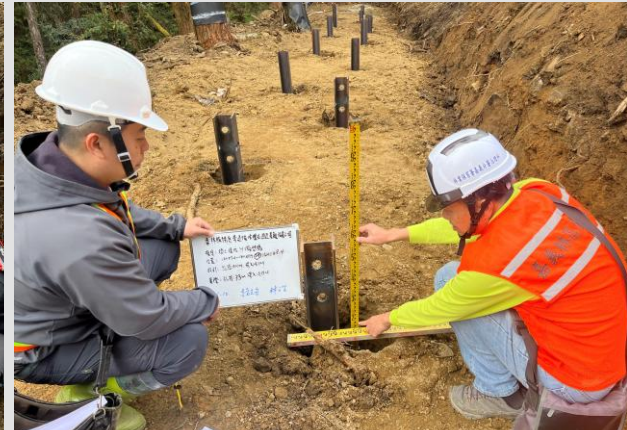
漿砌石護坡基礎微型樁查驗
