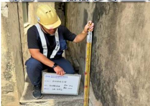
既有地坪打除施工抽查
