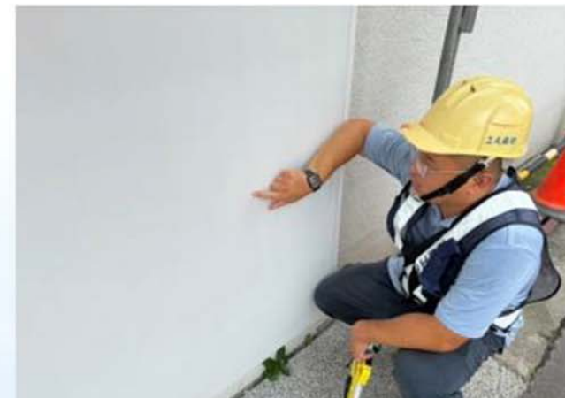
石頭漆施工抽查
