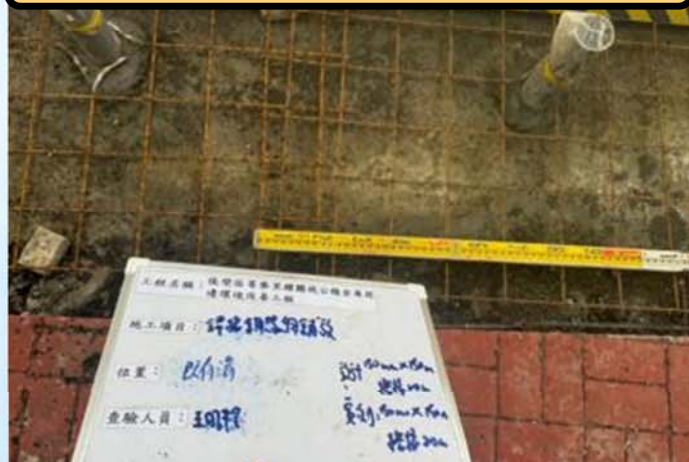
鋼線網搭接施工抽查
