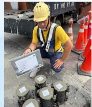
混凝土圓柱式體取樣
