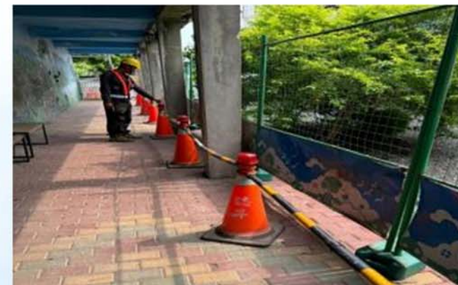
施工中加強安全措施
