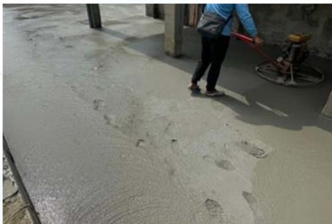
機械粉光去除浮水
