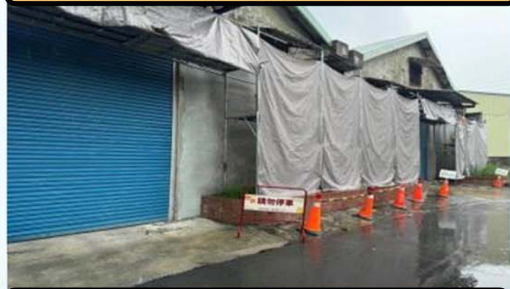
施工架全面覆蓋防塵網
