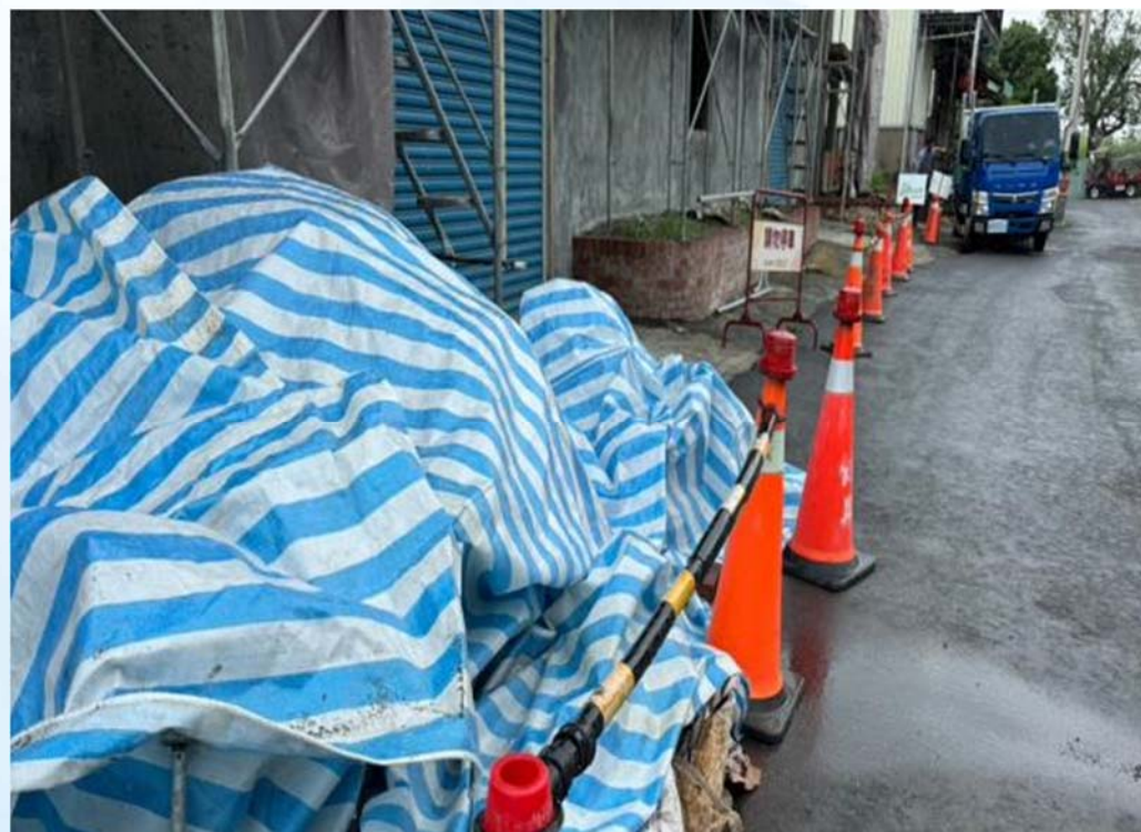
材料覆蓋並設置三角錐警示
