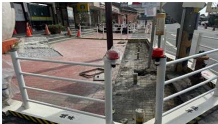
工區內加強安全措施
