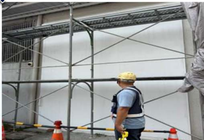
施工架組立施工抽查
