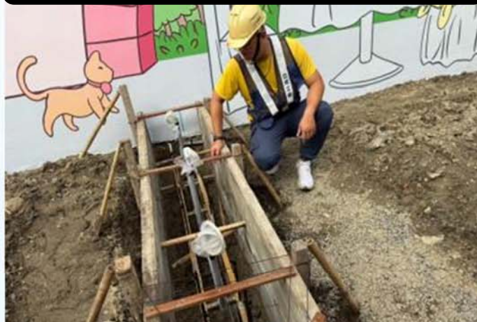
模板組立施工抽查
