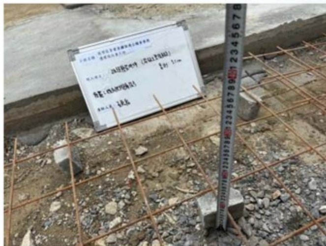
焊接鋼絲網鋪設
