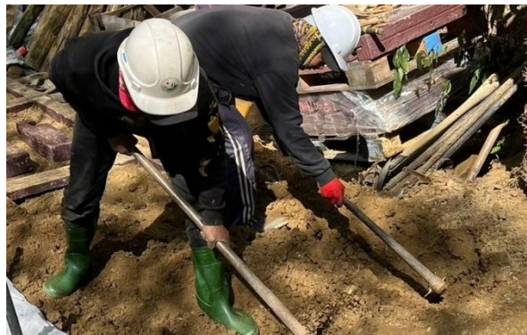
人工修築有分寸，挖填平衡不走樣
