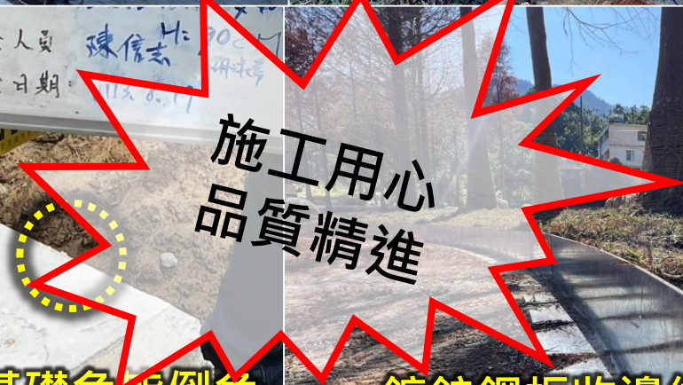
全區混凝土基礎角皆倒角
