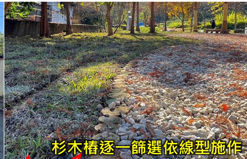
露骨材鋪面確實養護
