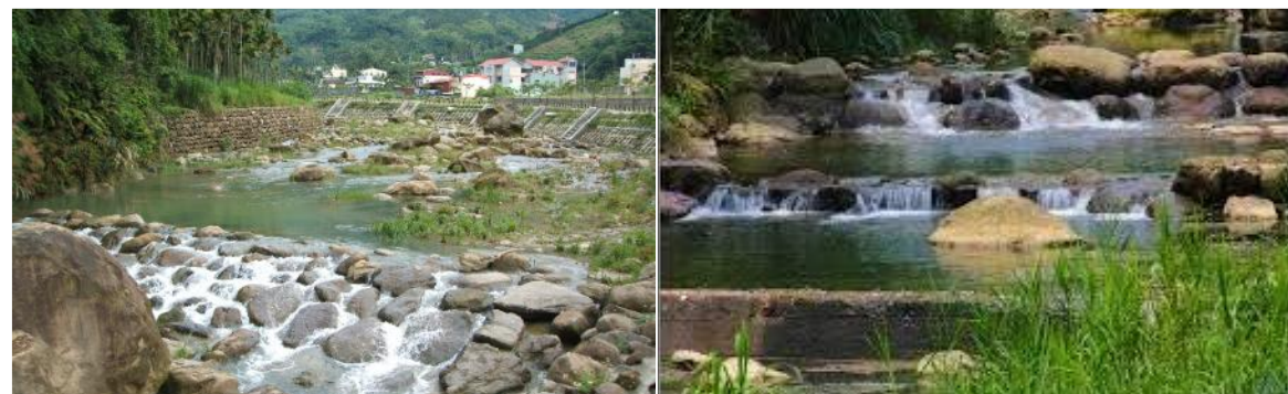
2004年新社鄉中和村抽藤坑土石流 (水保局)
