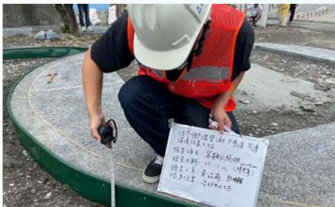
分隔板安裝施工抽查
