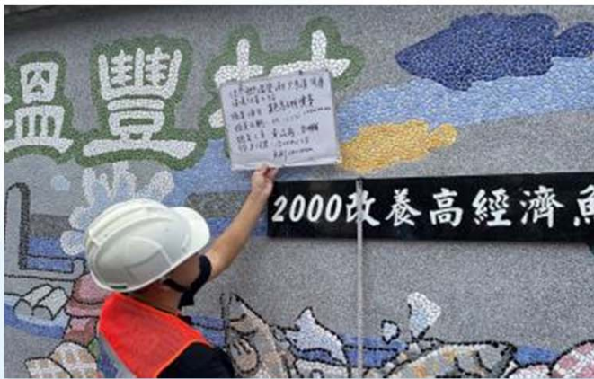
牆面安裝施工抽查
