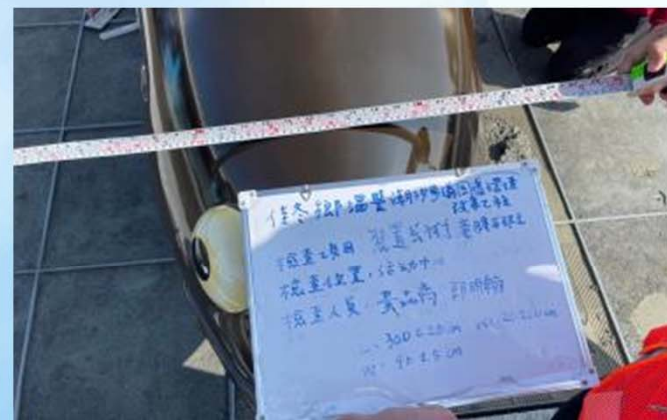
公仔安裝施工抽查
