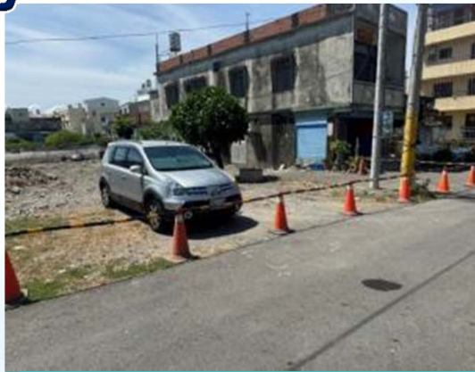
施工區與居民隔離以免誤闖
