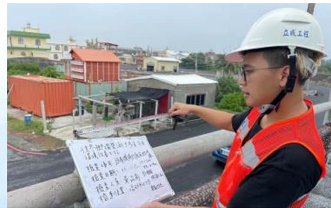
欄杆打底壓紋施工抽查
