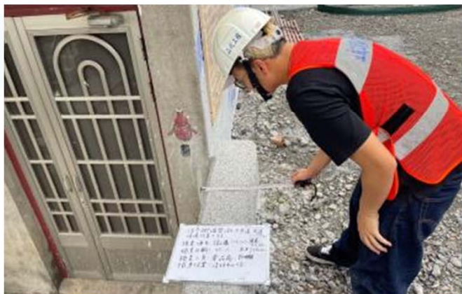
擋土牆施工抽查
