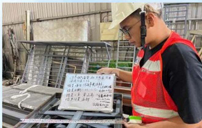
波浪式抿石板塊施工抽查
