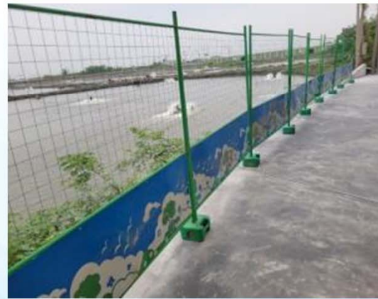
安全設施避免掉落
