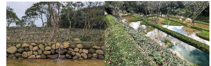
「傳統工法 - 梯田乾砌石護坡與植生護坡」代表了人與自然智慧的結合，強調了以生態為基礎的工程實踐。它們不僅能有效解決水土保持問題，更重要的是能創造多樣化的生態環境，恢復與傳承文化地景，實現工程效益、生態效益、環境美學和文化價值等多重目標，對於土地的永續利用和人類福祉具有深遠的意義。
