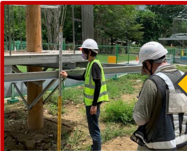
監造會同完成面高度檢查
