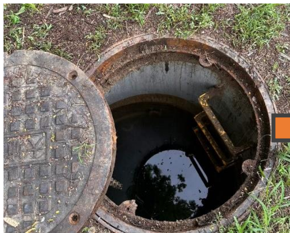
現場確認地下管線
