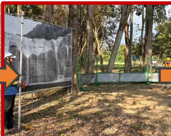
監造會同預力桿設置檢查
