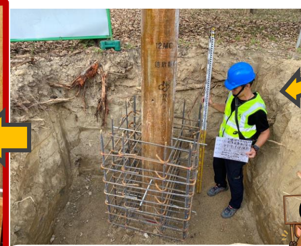
鋼筋間距檢查
