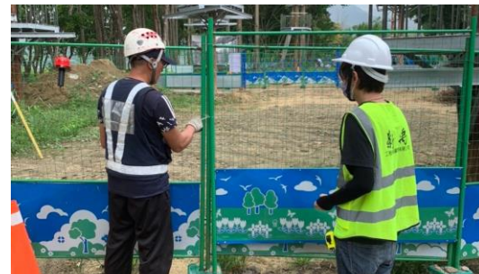
護欄鋼索固定
