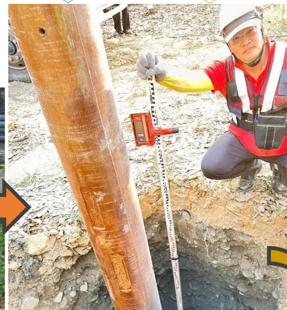
預力桿埋設深度確認
