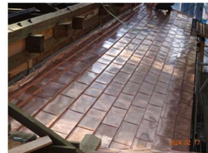
完成面表面平整無漏釘或破口 (20240217)
