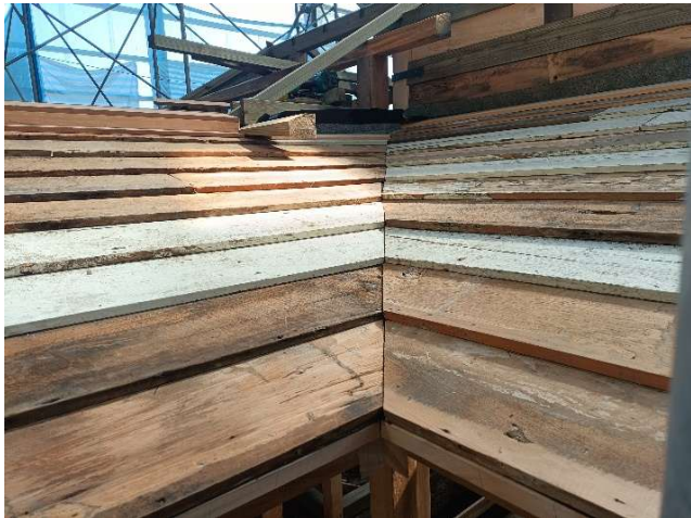
使用舊雨淋板修復鍛鋪雨庇底板 (20240103)
