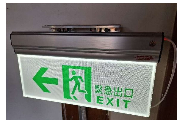
(2)火警備設備-LED避難方向指示燈C級
