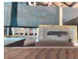
天井板通氣口防作(20240522)
