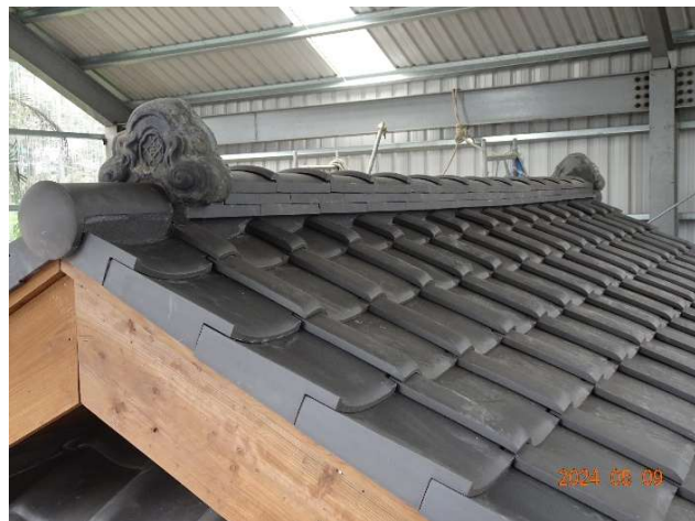
(11) 屋頂-既有黑燠瓦、舊瓦鋪設完成
