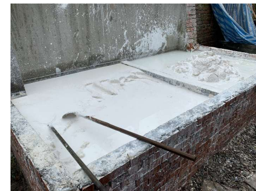
養灰池養灰攪拌 (20240125)
