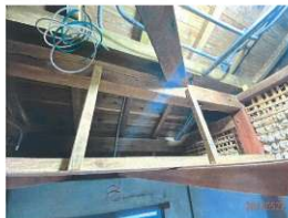
吊承受鋼吊承(天花吊樑)及補強吊樑(20240522)
