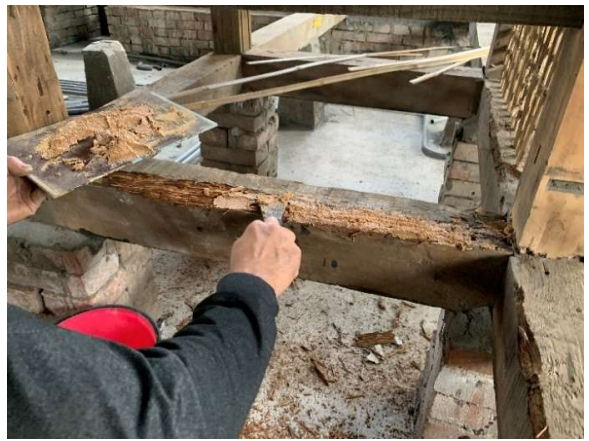
(3) 床組工程-土臺修補木屑 + 木料專用修補型EPOXY， 修鑿為易於修補之狀態
