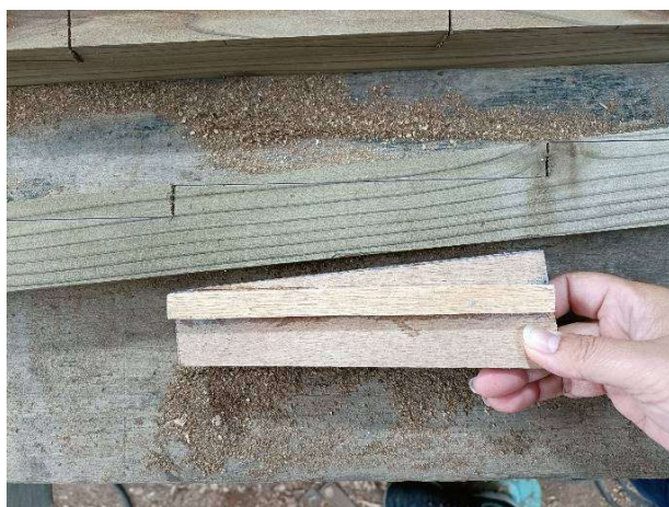
押緣施作時，木作師傅使用 樣板工具，該樣板作為間距 固定功能
