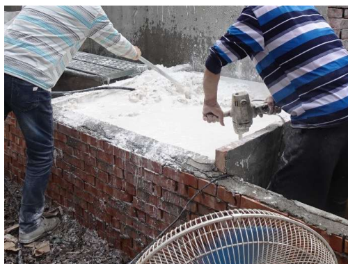
手持電動攪拌器攪拌 均勻(20240111)
