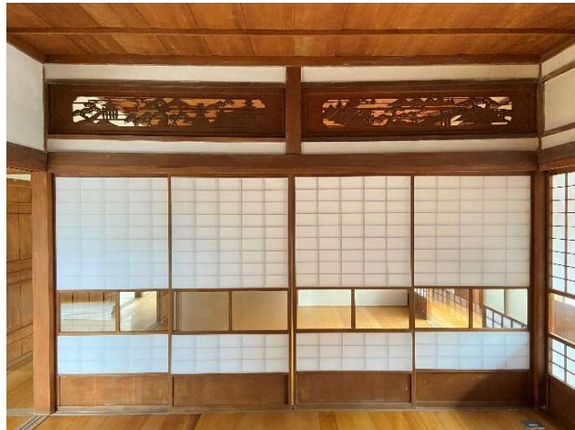
(14) 門窗工程-D9台灣檜木左右推拉門，上方透雕木板欄間，表面上護木漆，貼純白無花紋壁紙，下方裝設清玻璃。
