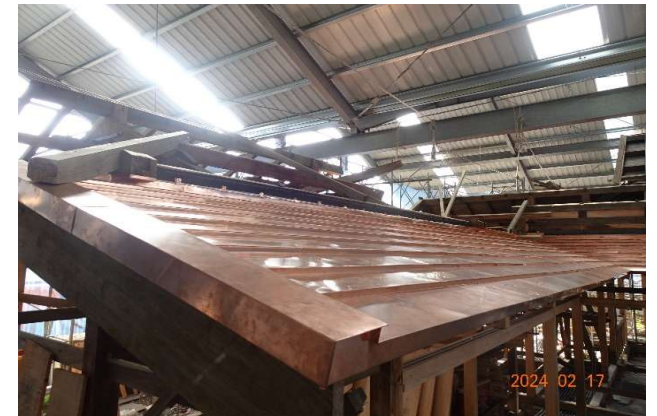
簷口前緣起手銅泛水收邊，多重 方向的銅片搭接、簷口瓦起手的 收邊細節(20240217)
