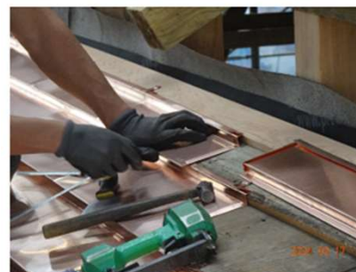
將鋼片卡扣敲打進下方的鋼片卡扣固定 (20240217)
