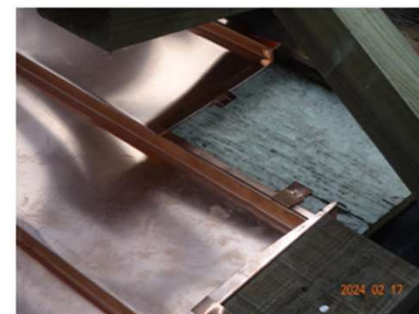
施作面平整，無漏釘或破口 (20240217)
