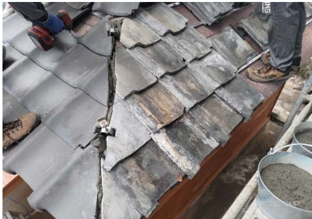
新舊瓦介面，第一行右角瓦，以不鏽鋼螺絲釘及1:1水泥砂漿加強鎖固 (20240507)
