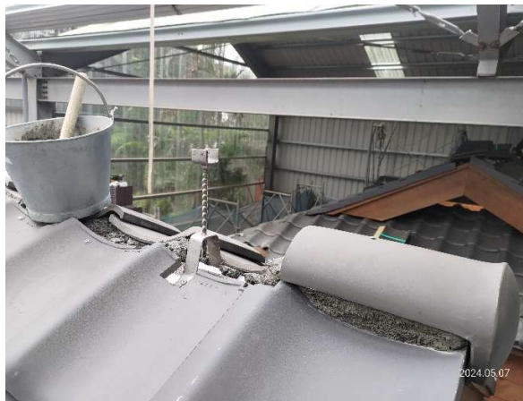
扶脊架(棟金具)所固在掛瓦條上，於主瓦上填上1:1水泥砂漿，再蓋上丸巴 (20240507)
