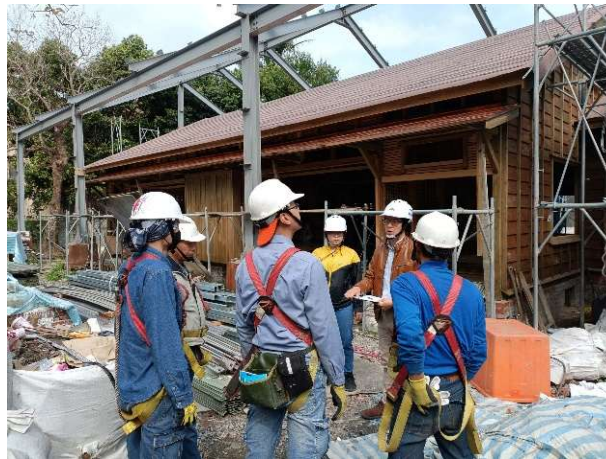
高空作業施工前工具箱會議
