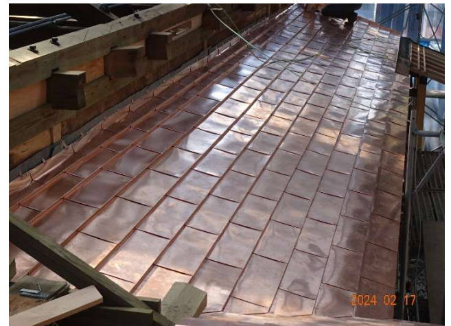
鋪設時，銅皮貼密於野地板上， 橫、縱向間放樣平行及垂直精準 (20240217)
