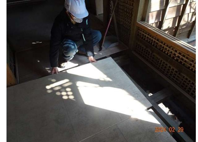
高架地板，開口區確實封閉
