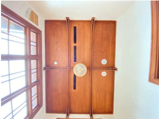
(13) 天井板-洋式天井之竿緣形式特別，依原貌修復。
