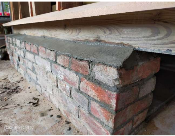
(2) 基礎工程-仿作布基礎 上方導水施作完成
