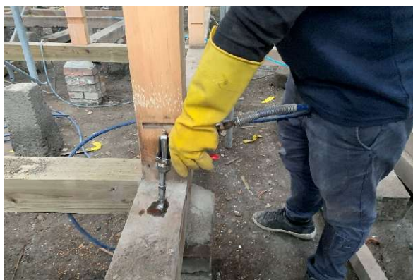
(2)端點可逆式壓力灌注工法-藥劑灌注
