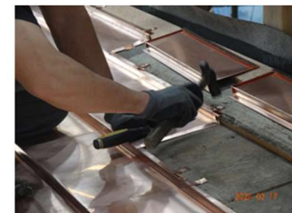
鋼吊子固定，拍打整平（20240217）
