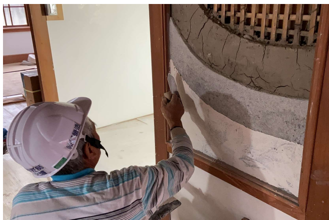
(5)內牆體-小舞壁牆面層施作
