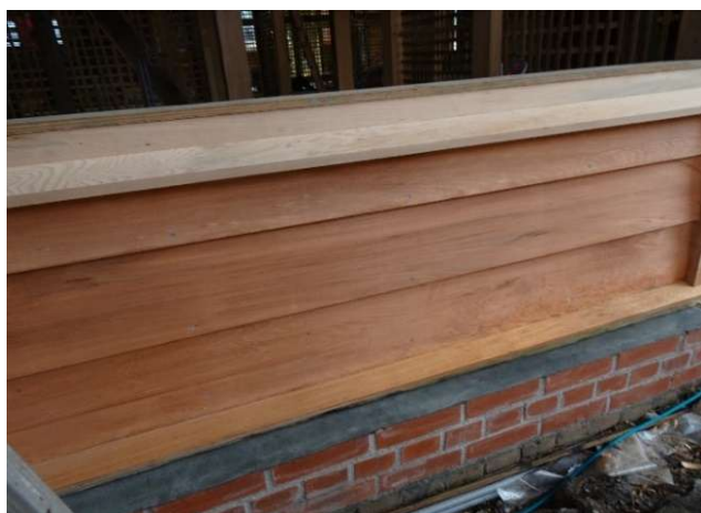
1.5寸不鏽鋼斜紋釘固定在間柱 上，間距19cm，依照間柱調 整，使用漂流木臺檯
