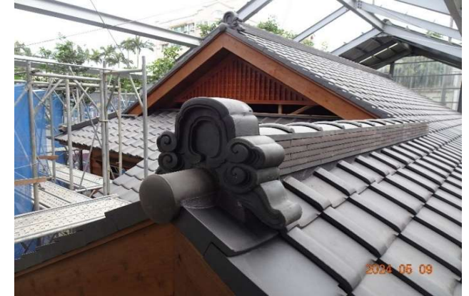
中脊及大鬼頭，主屋面後坡完成外觀照片(20240609)
