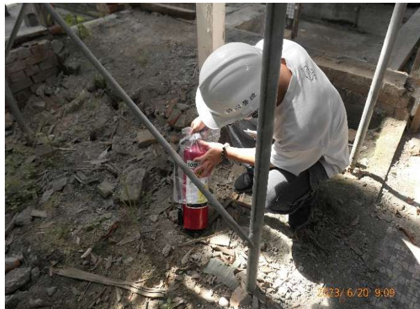
抽查滅火器有效期限
