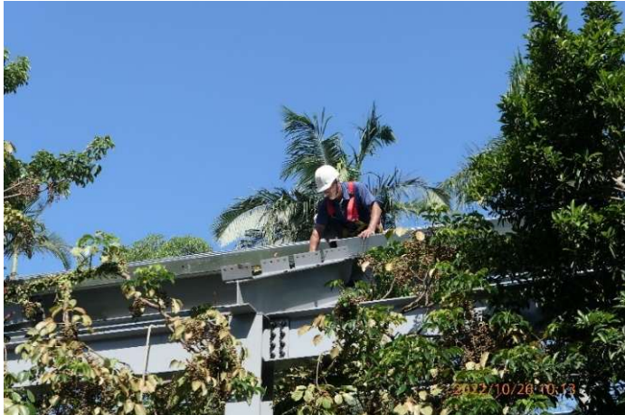
高空作業配設安全掛鉤
