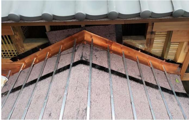
銅作御水板收邊樣式，確認瓦作與牆體間斷水處理的細節 (20240426)
