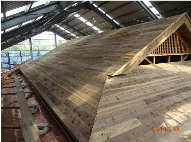
(10) 屋面-野地板施作完成
