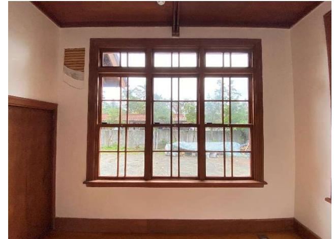
(15) 門窗工程-DW1台灣檜木上下推拉窗，上方固定窗，裝設十字花玻璃，五金狀態良好，表面上護木漆，裝設清玻璃。
