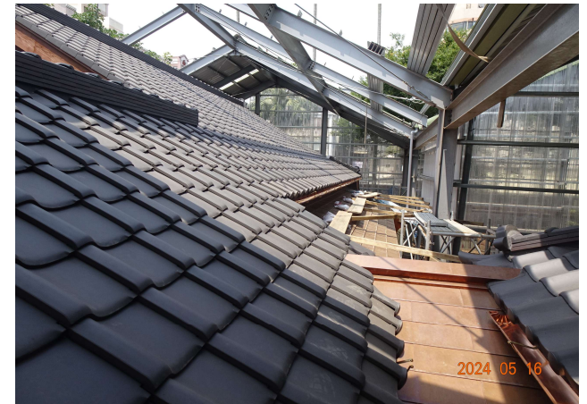
後坡與增建的過渡空間，銅瓦與黑燠瓦高低落差及不同介面處理，最費心討論與施工的位置 (20240516)
