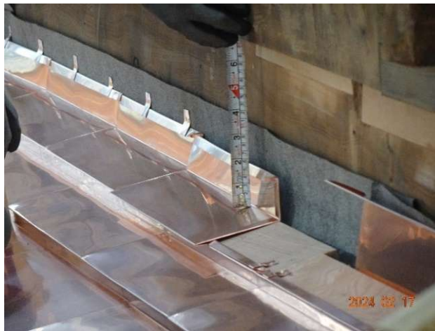
泛水板扣接本體，向上延伸高度 5cm ( 20240217 )
