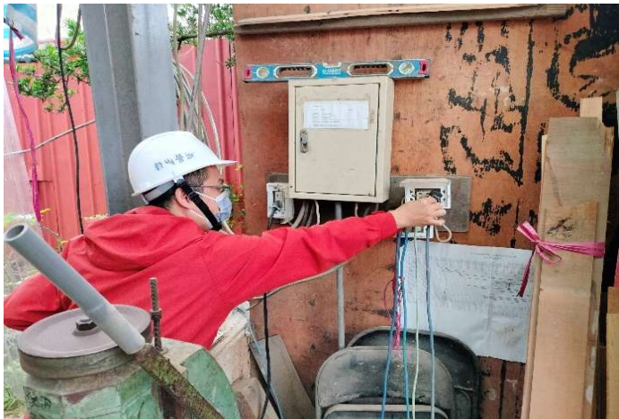
監造單位抽查，開關箱、插座安裝
