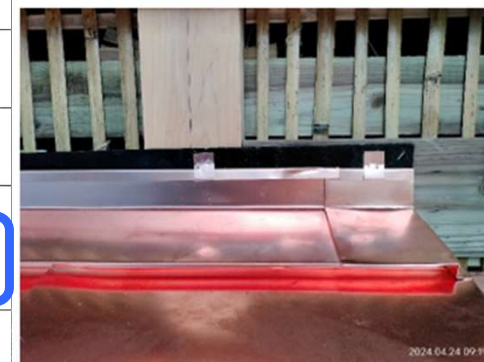
泛水板銅片延伸5cm, 立面鋪設無破口 (20240424)
