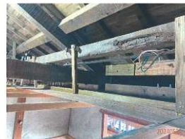
在補強吊樑引孔，由上而下用不銹鋼螺絲釘穿過天井板，鎖固到吊樑(20240522)
