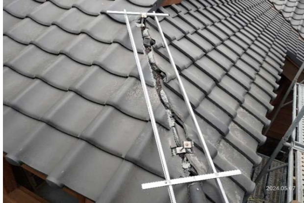
於陽角處(斜脊)製作模具，倒入1:1水泥砂漿 (20240507)
