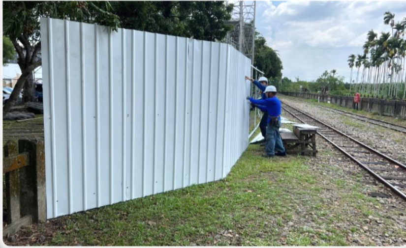
工地設置管制圍籬
