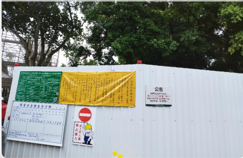
設置職安告示牌
