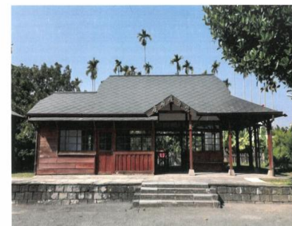
鹿麻產車站及周邊環境整修工程 工作報告書
