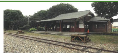
阿里山林業鐵路鹿麻產車站及周邊環境整修工程 基礎調查報告書
