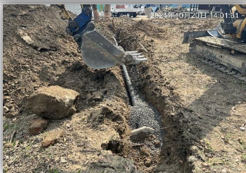
戶外地表埋設透水管
