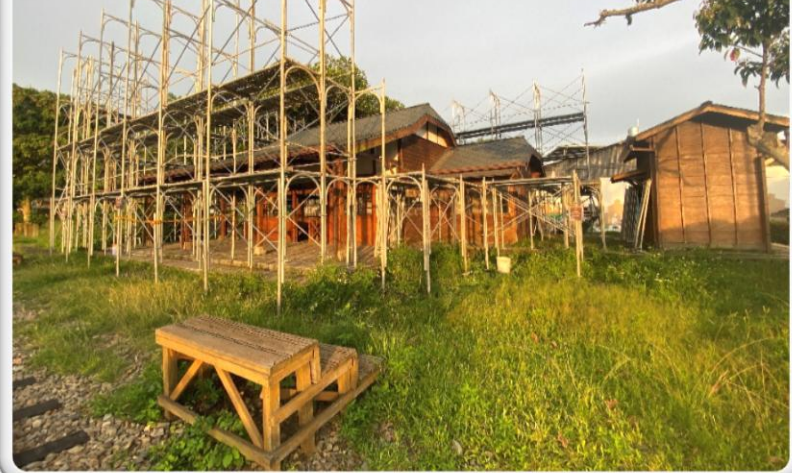
施工架及上下設備
