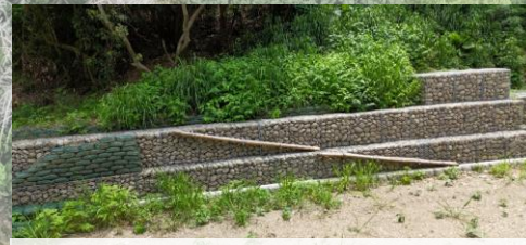
現地竹材製作動物通道，兼顧生態與在地取材
