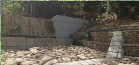
現地塊石填料施工，減少混凝土鋼筋用量降碳護環境
