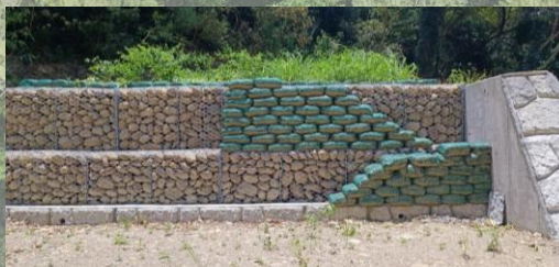
土包袋推砌階梯式動物通道，提供野生動物逃生與遷移路徑
