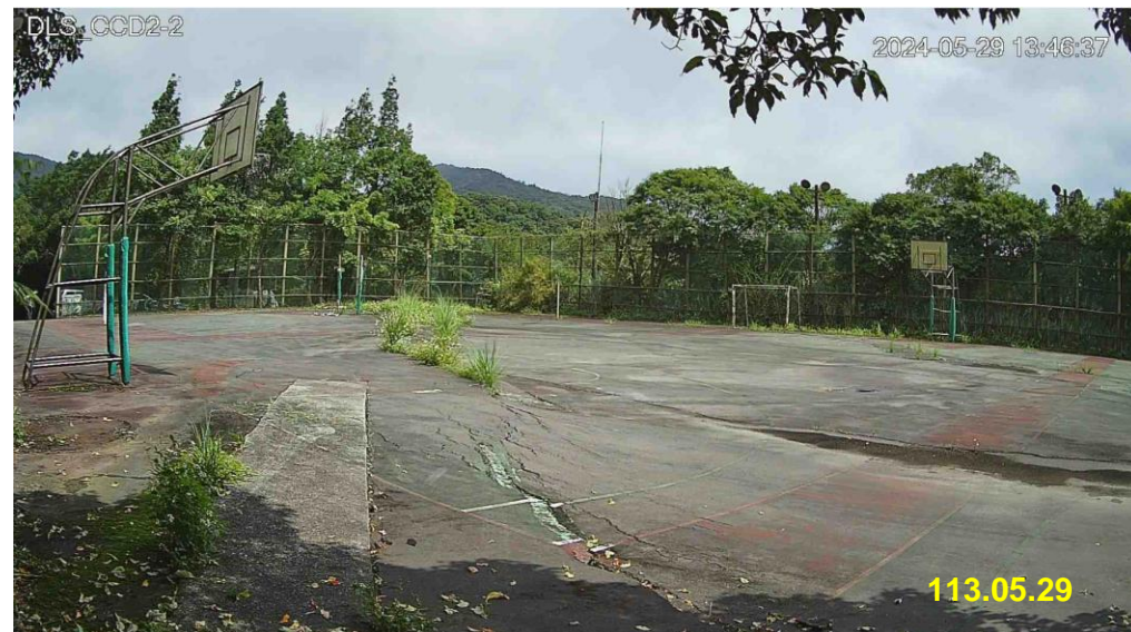
利用 CCD 攝影機觀察地表裂縫變化
