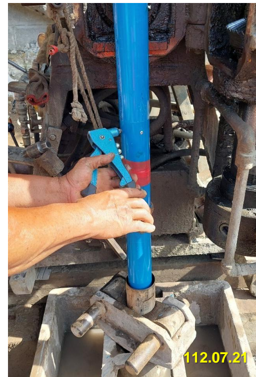
傾斜管、水位井安裝
