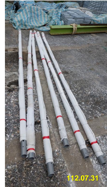
傾斜管、水位井安裝
