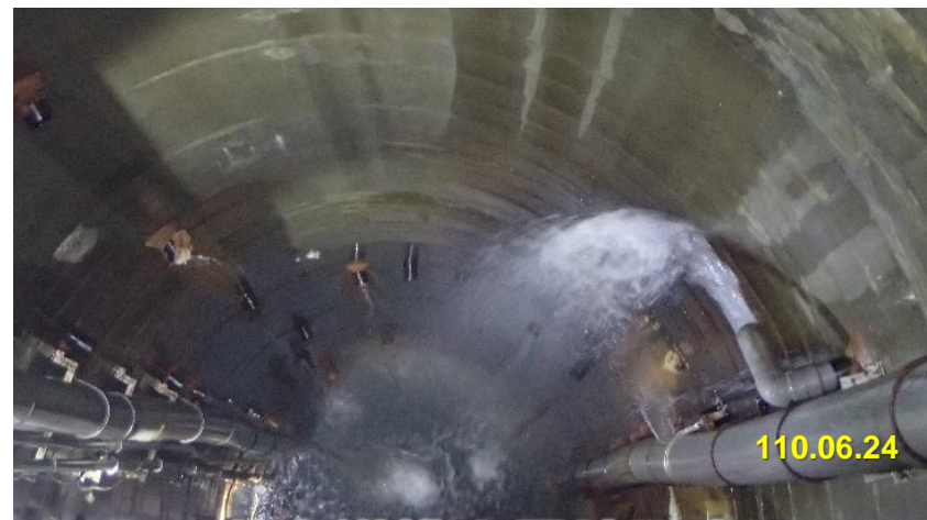
T2井有導排大量地下水
