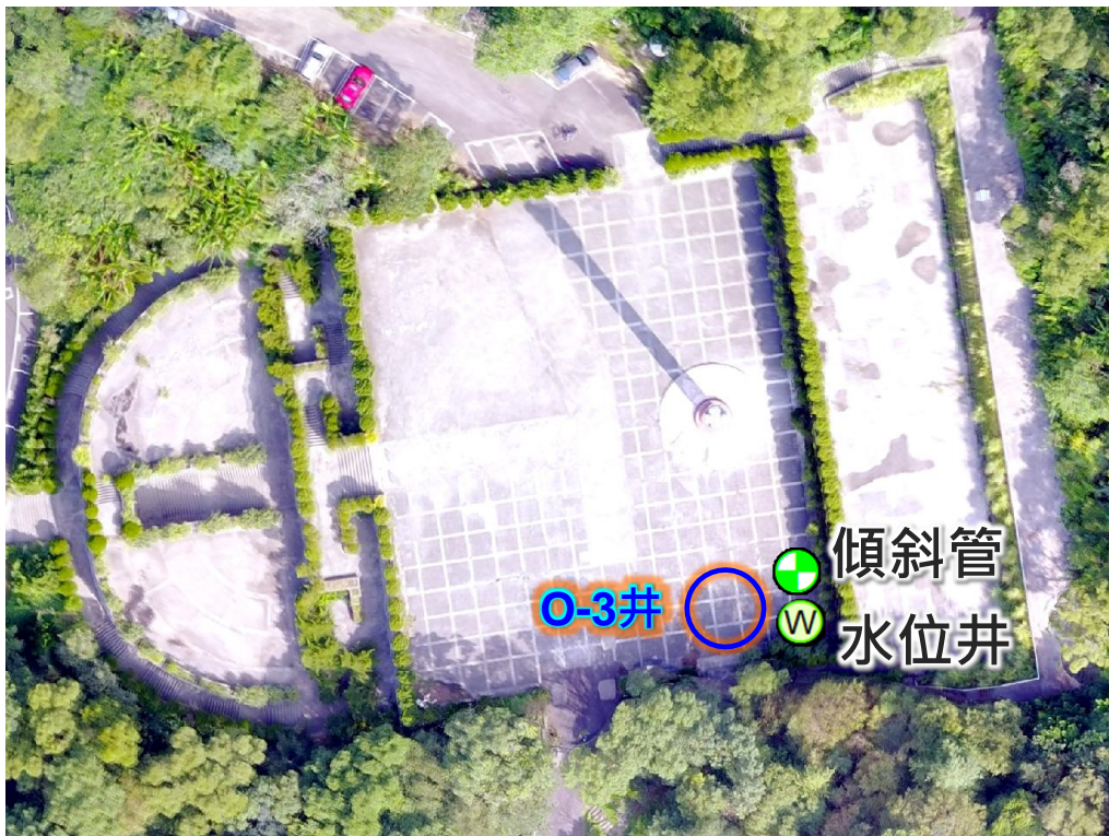
地質鑽孔位於集水井上邊坡側
