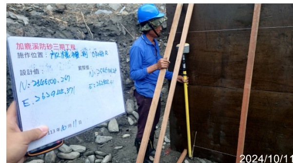
施工放樣複測
