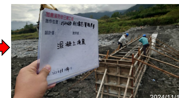
翼牆混凝土澆置
