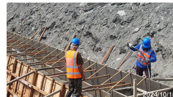
基礎混凝土澆置
