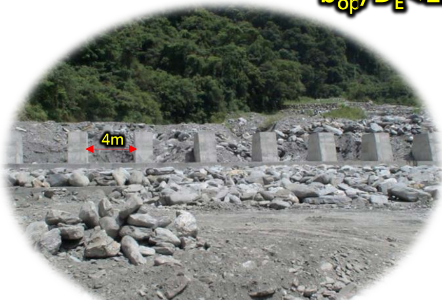
(林保署台東分署-上游) 加鹿溪整流二期工程
