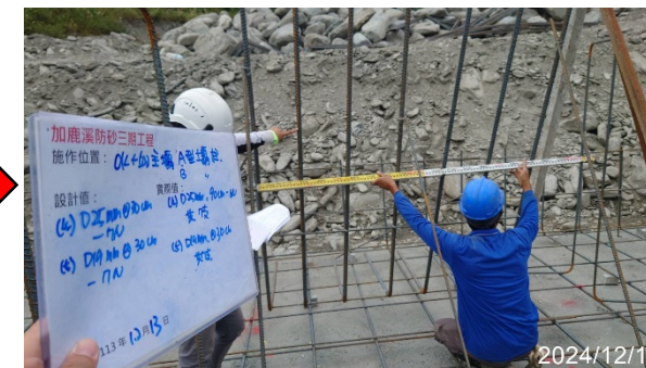
壩柱鋼筋查驗
