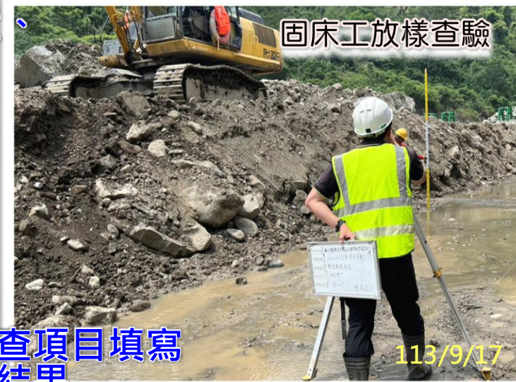
固床工翼牆尺寸查驗
