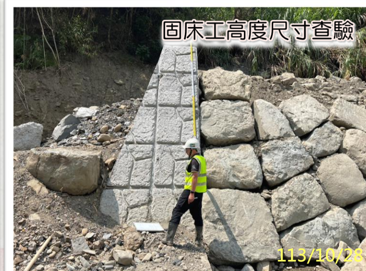
固床工翼牆尺寸查驗
