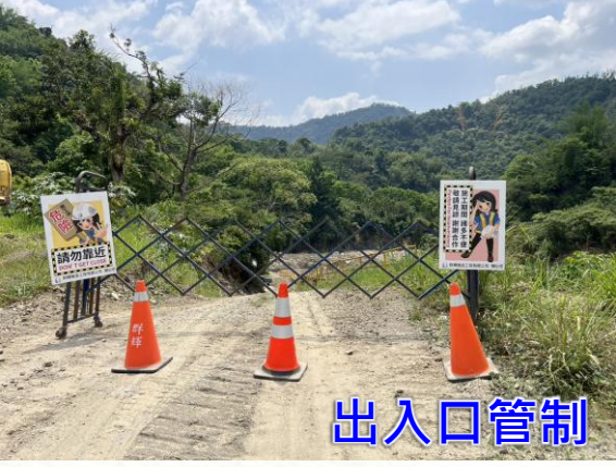
工地安全管理守則
