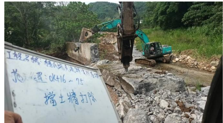
混凝土碎塊破碎
