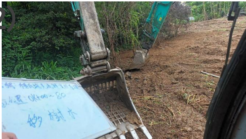
施工前樹木移植至保護區
