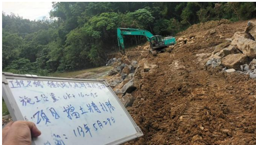
既有擋土牆拆除
