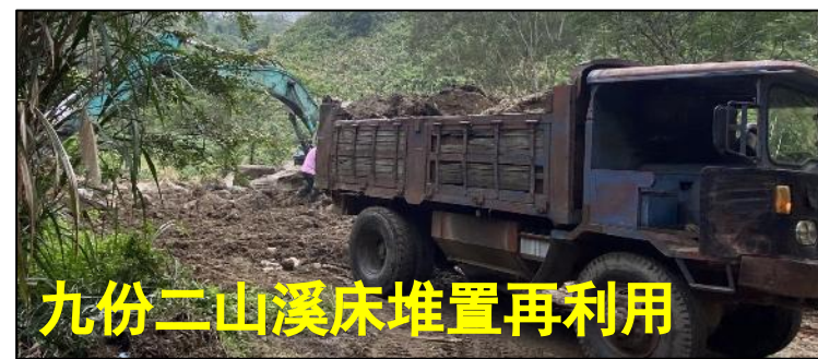
混凝土碎塊裝載運輸
