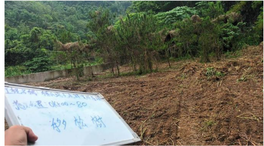
施工前樹木移植至保護區
